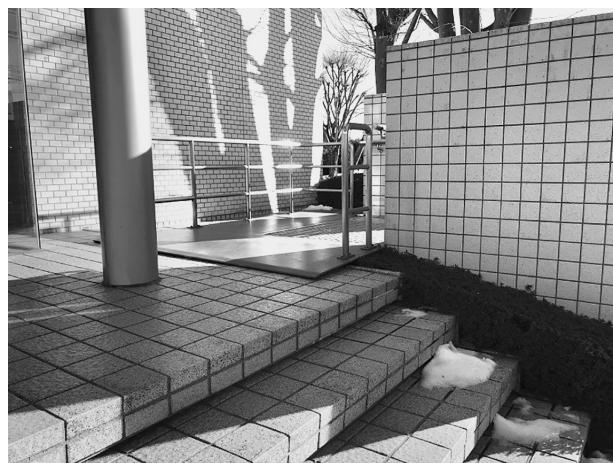
写真11 スロープのエクspansionジョイント
