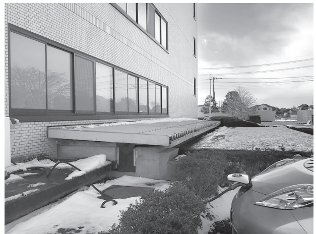
写真7 載荷試験部 (載荷装置を外し、屋根を設置)
