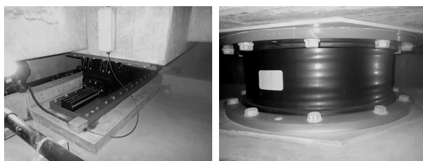
写真9 基礎部 免震装置
