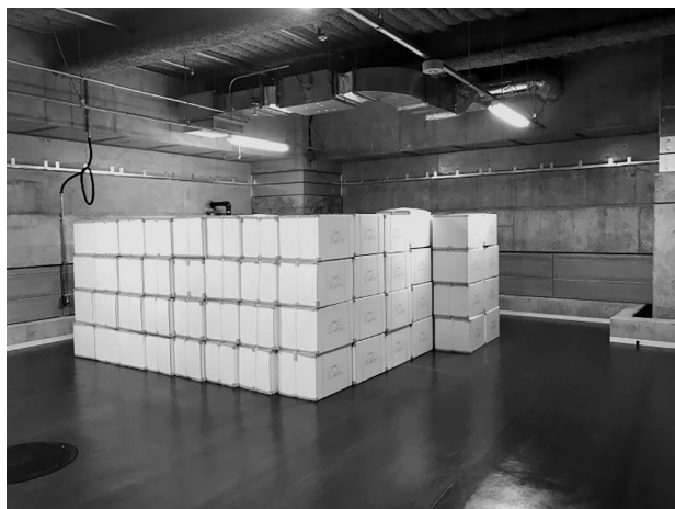
写真8 B1階 柱頭免震部 (防災倉庫)
