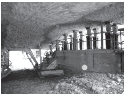
建物支持地盤の全掘削
