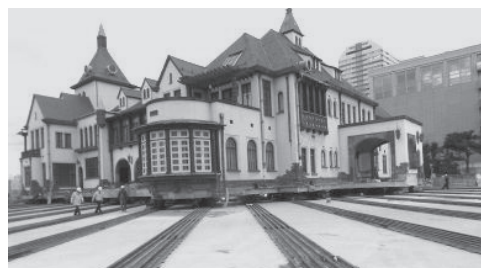
旧李王家曳家の状況
