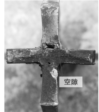
図 8 溶接部の空隙 (試験体 7)
