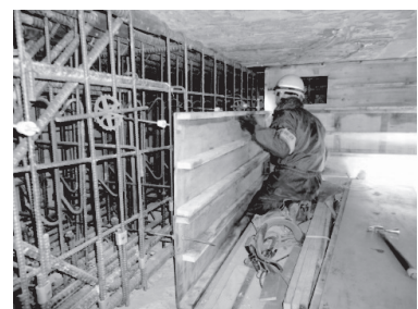
ピット内での梁補強作業
