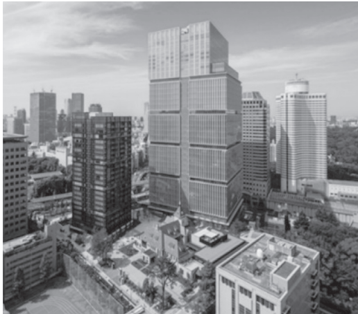
建物外観（北東側）
