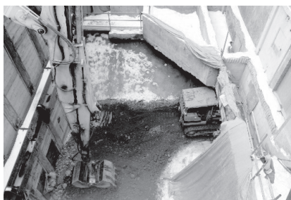
ミニコンボによる建物下掘削
