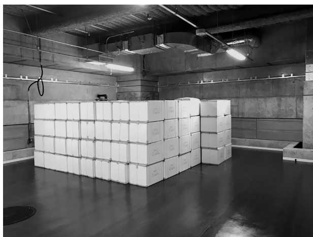
写真8 B1階 柱頭免震部 (防災倉庫)
