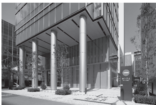
写真2 吹抜け空間の長柱
