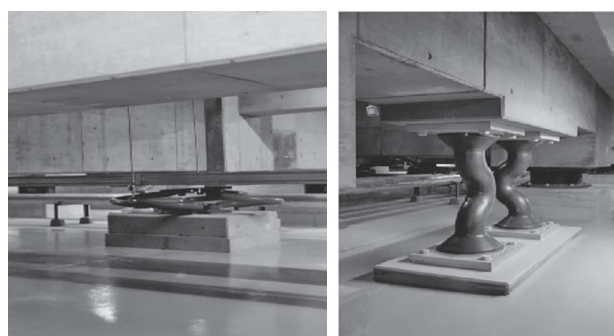
図3 鋼棒ダンパーと鉛ダンパー
