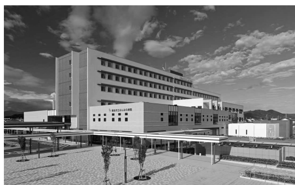
写真1 前面道路からの外観
