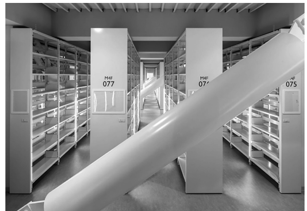
写真3 閉架書庫と耐震ブレース
