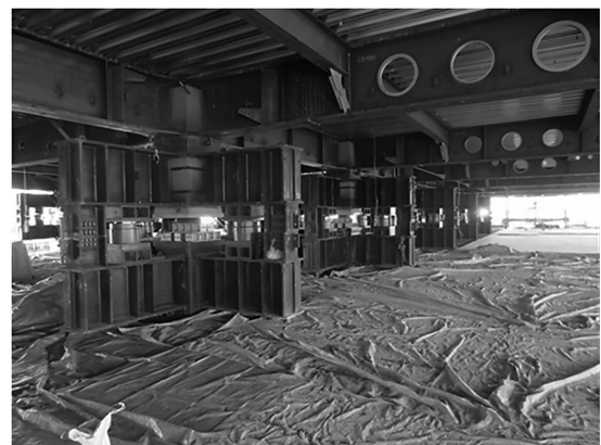
写真5 ジャッキ配置状況
