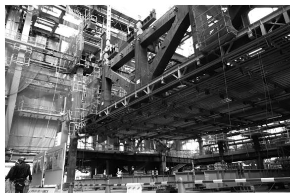
写真4 リフトアップ状況
