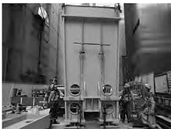
写真2 通し壁柱の建方状況（大成建設より提供）
