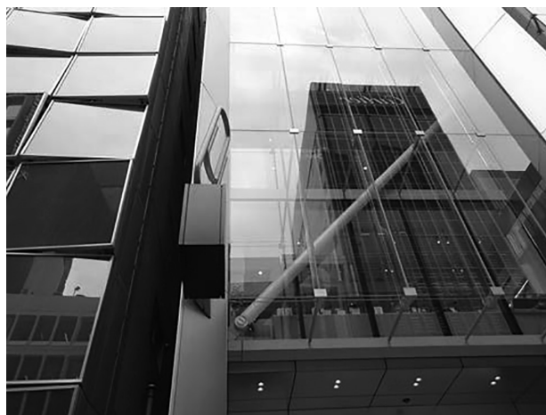
写真3 エントランスよりファサード見上げ
