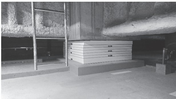
写真9 積層ゴム支承の耐火被覆 (本館免震層)
