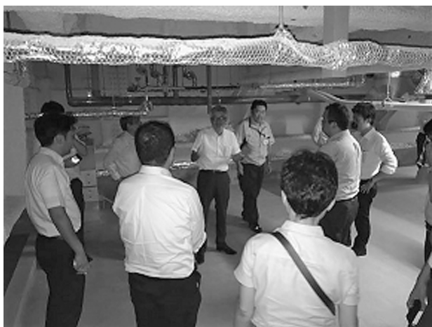
写真3 免震層の見学
