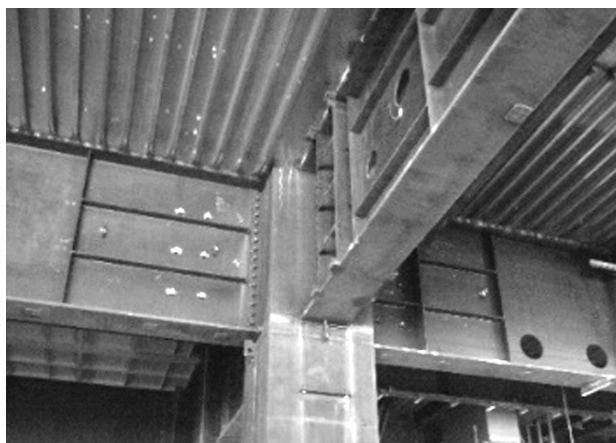
写真4 新規開発梁端部の現場外観
