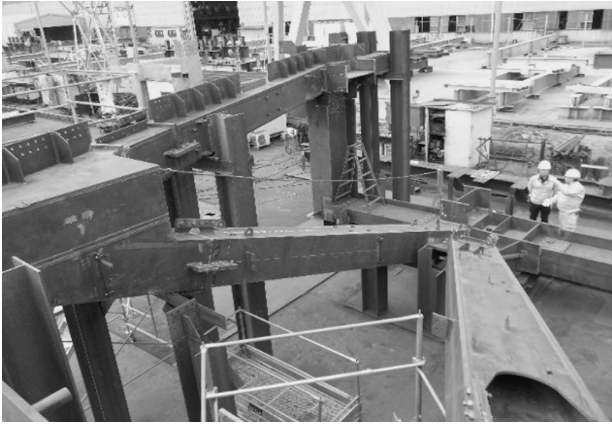
写真6 トランスファートラスの仮組状況
