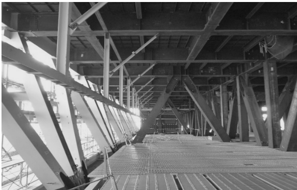
写真7 トランスファートラスの建方状況
