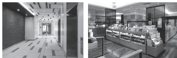
免震改修後の1階E/Vホールと和紙店舗(免震化を意識させない納まり)
