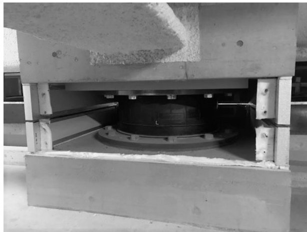
写真2 耐火被覆を取り外した積層ゴム
