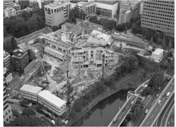
写真8 旧赤坂プリンスホテル 既存躯体の山留壁への利用状況
