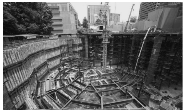
写真9 大深度アースアンカー工法
