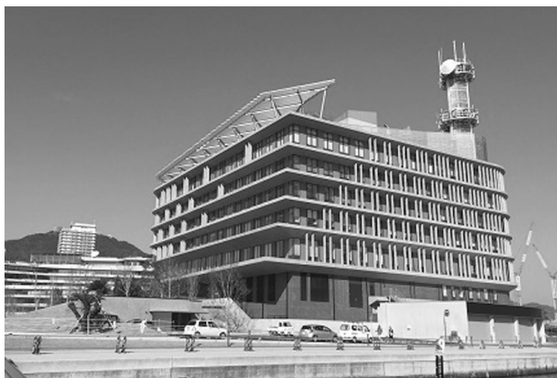
写真9 長崎県庁舎の全景
