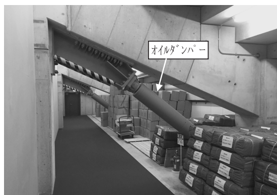
写真9 1階メインスタンド裏通路
