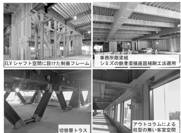
図3 構造架構概要
