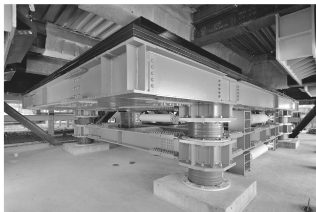
図7 SMD設置状況
