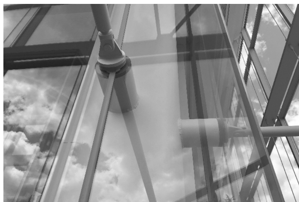
写真9 ロッド端部詳細図
