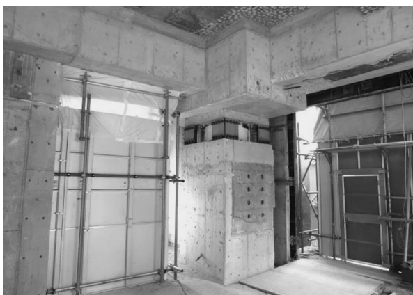
写真7 免震装置および仮設プレート設置
