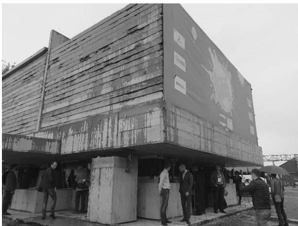
写真3 実験用3次元免震建物
