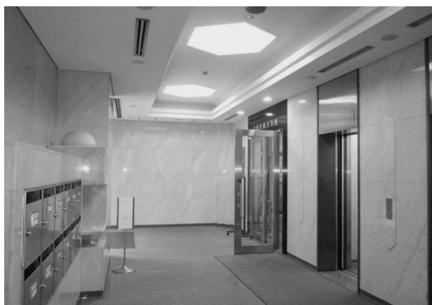
写真14 1階エレベータホール（改修前）
