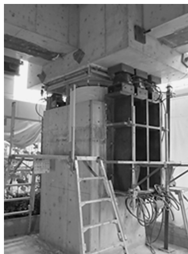
写真8 4～6台の仮設ジャッキで各柱の建物重量を支える
