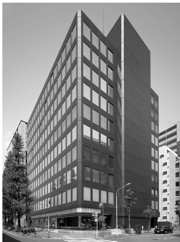
写真3 免震改修後の小津本館ビル（2016年撮影）
