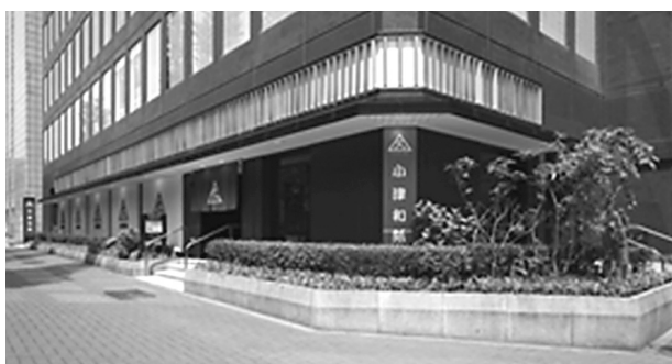
写真17 1階エントランス周りの外装（改修後） （免震水平スリットを底の上部に設け、使用可能な部材は極力再利用）
