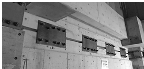
写真10 仮設プレートにより耐震安全性を確保
