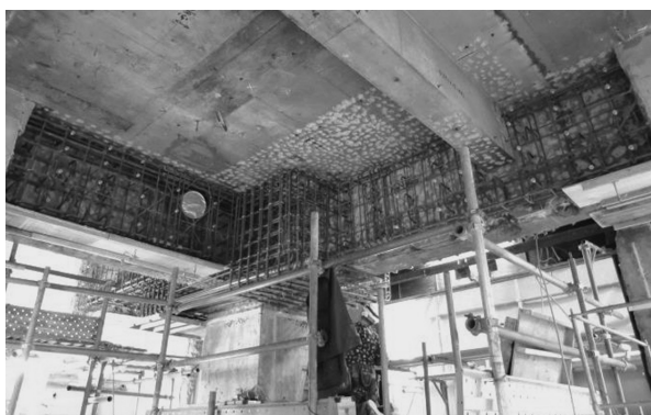
写真5 2階大梁増打ちおよびキャピタルの配筋
