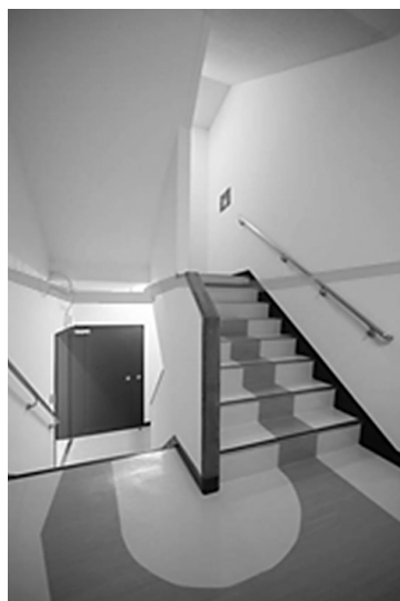
写真12 屋内避難階段 （階段室壁の稼働範囲を色分けして表示） （写真中央のグレーの線は免震水平スリットの位置を示す）
