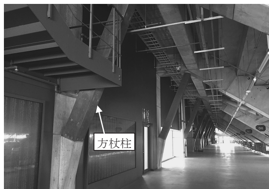
写真8 高強度コンクリート方杖柱
