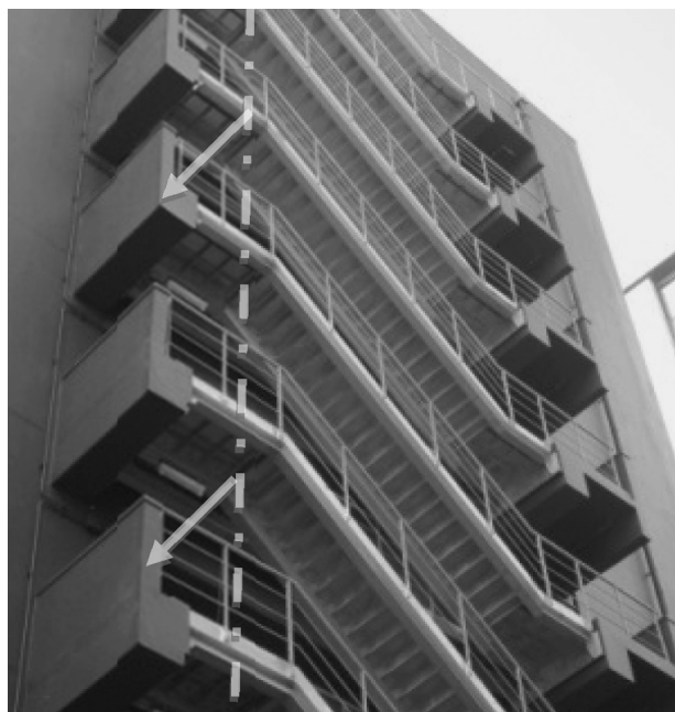
写真11 外部避難階段 全景（改修後） （500mmセットバック、RC造からS造階段へ更新）
