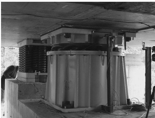
写真4 ゲルブスプリング（奥）と粘性ダンパー（手前）
