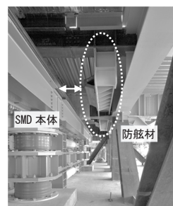
図8 フェールセーフ機構
