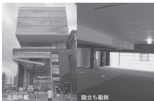
写真5 ジャッキダウン・ベント撤去後
