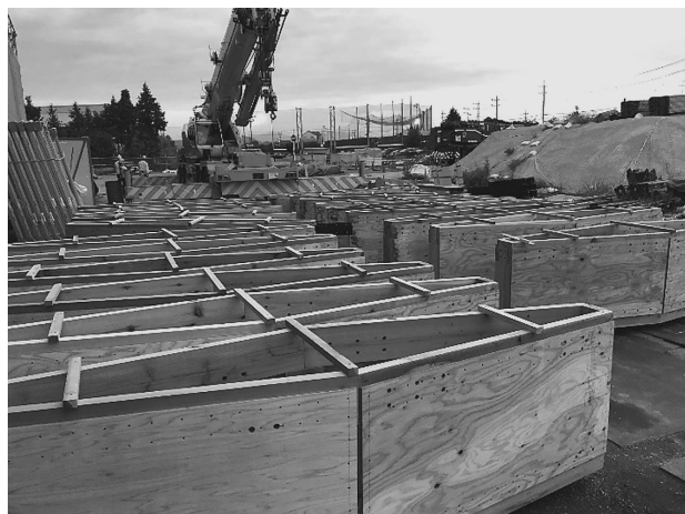
写真2 施工時の木屋根6角形ユニット
