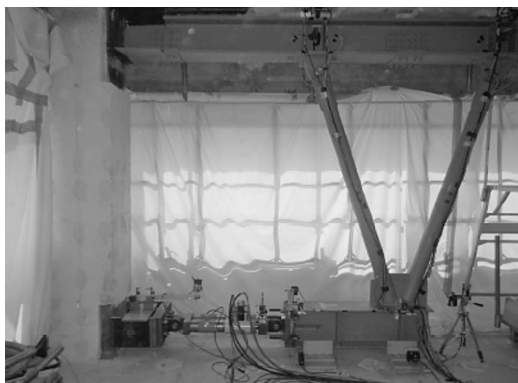
写真4 剛性確認試験
