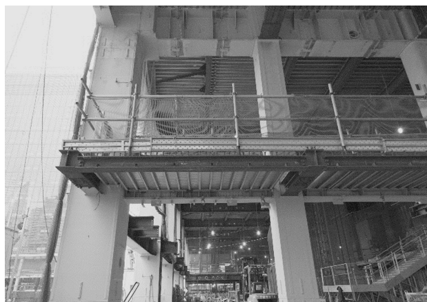
写真7 600mm角の超高強度CFT柱（写真右） 写真左は1000mm角の一般CFT柱
