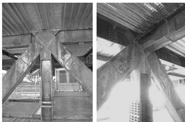
写真3 ブレースチューブ交点の施工状況
