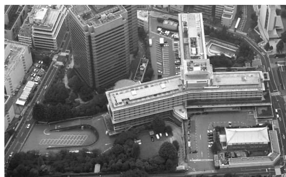
写真1 ホテルオークラ東京・本館（解体前）
