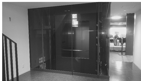
写真10 エレベーター
