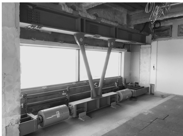
写真3 制振部材設置状況
