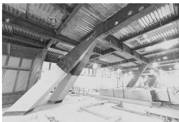
写真6 構造切替階の鋳鋼接合部
