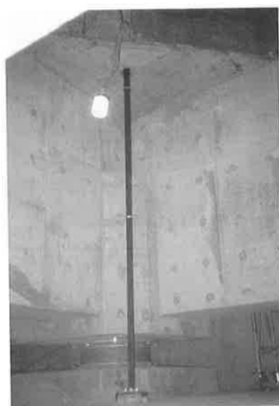
写真—2 引張抵抗用PC鋼材
