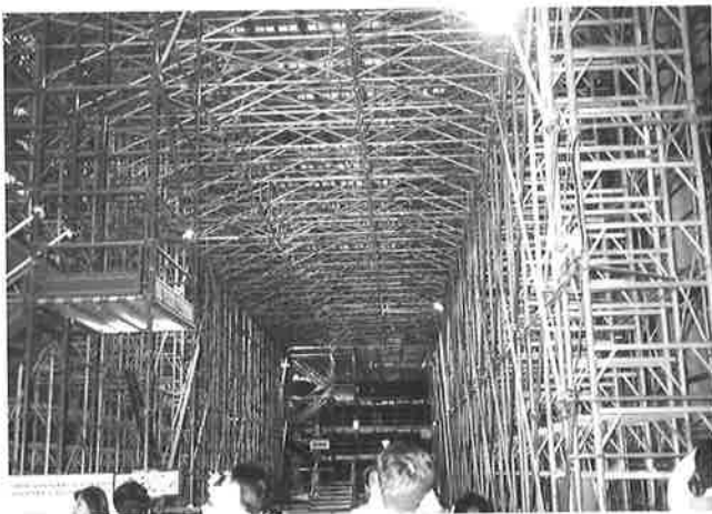
写真-4-1 補強工事状況
