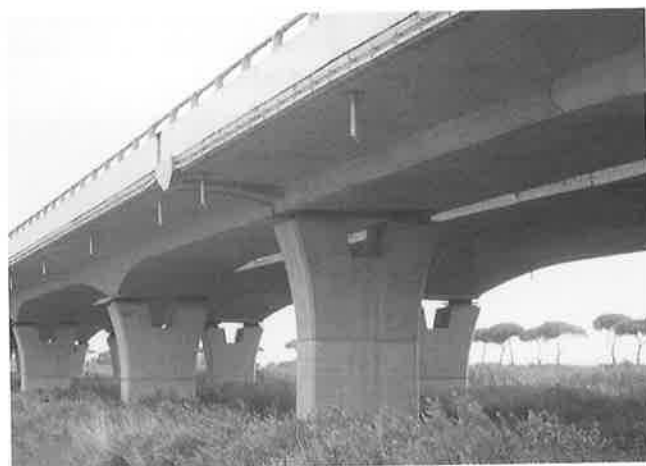
写真-2-9 免震高架橋外観
