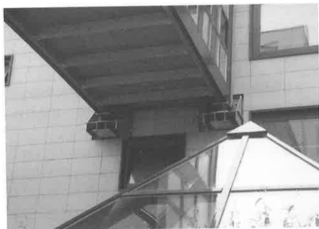
写真-2-3 渡り廊下支点部(400mmφ積層ゴム)
