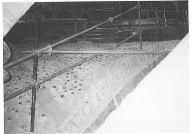
写真-4-2 ヴォールト部の補強状況
