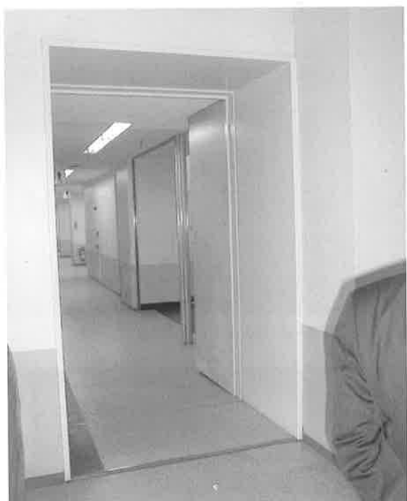
写真-8 既存建物との取合いの実際
