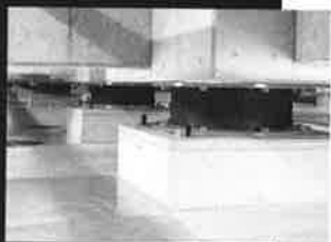
免震装置設置状況 LRB (φ1200)
