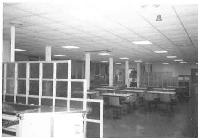
写真-3-2 建物内部の状況
