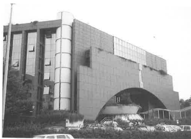
写真-2-6 建物外観
