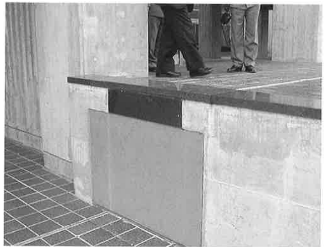
写真-5 段差のあるクリアランス処理
