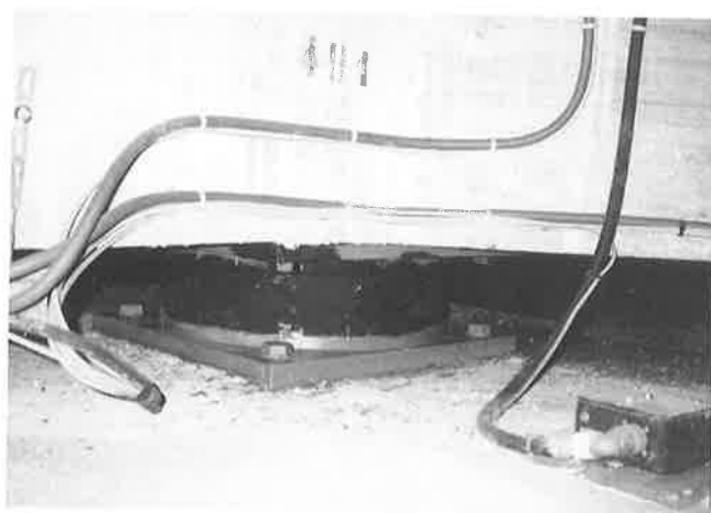
写真-2-7 積層ゴム設置状況
