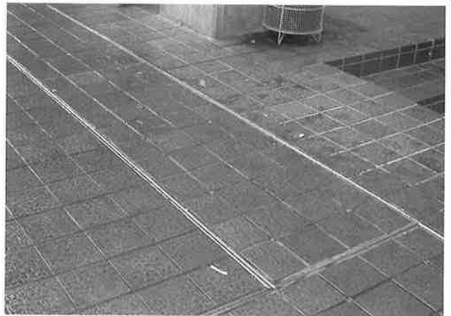
写真-4 1階のクリアランス処理
