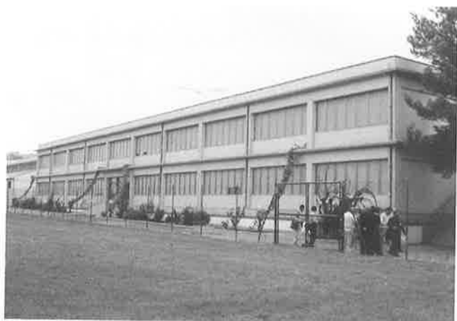
写真-2-4 建物外観
