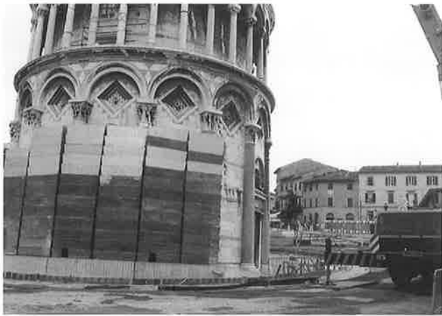
写真-4-3 補強状況
