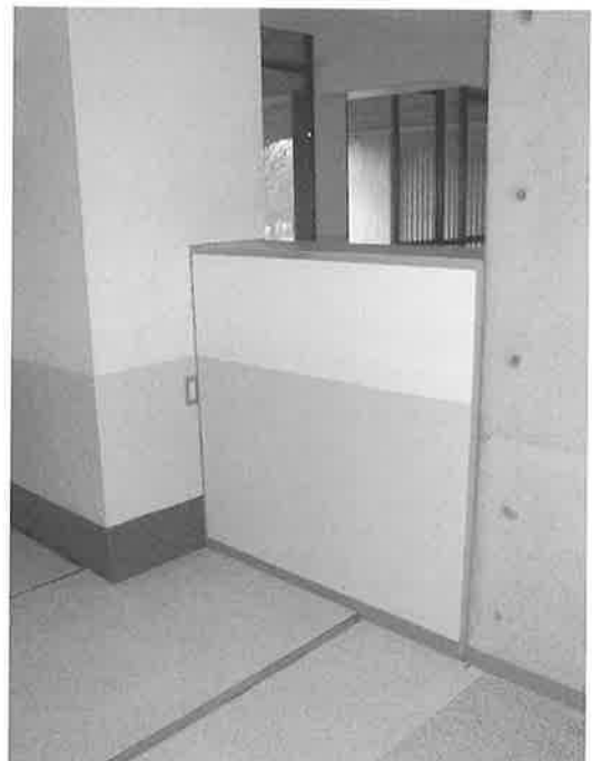
写真-6 内部のクリアランス処理
