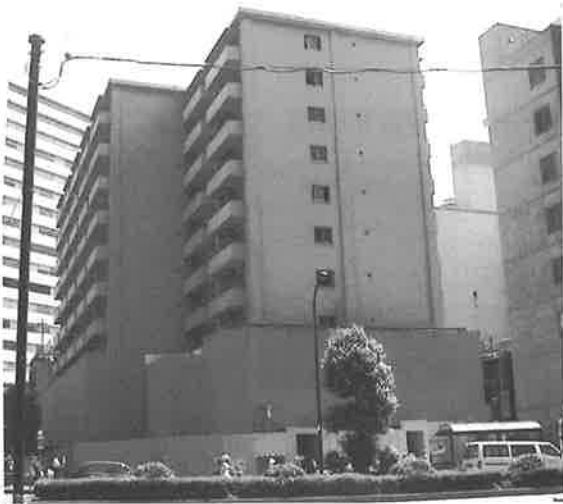
図-1 建物全景（耐震改修工事中）
