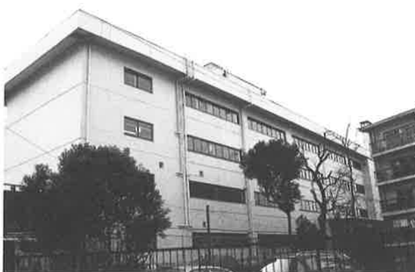
写真-1 耐震改修工事中の校舎
