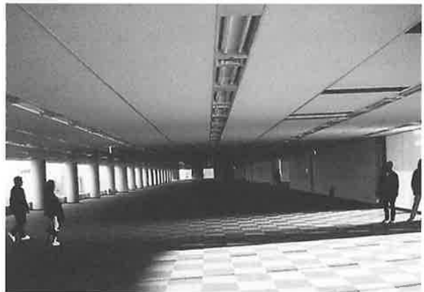
写真-7 広々とした事務室（柱はCFTの無耐火被覆としている）
