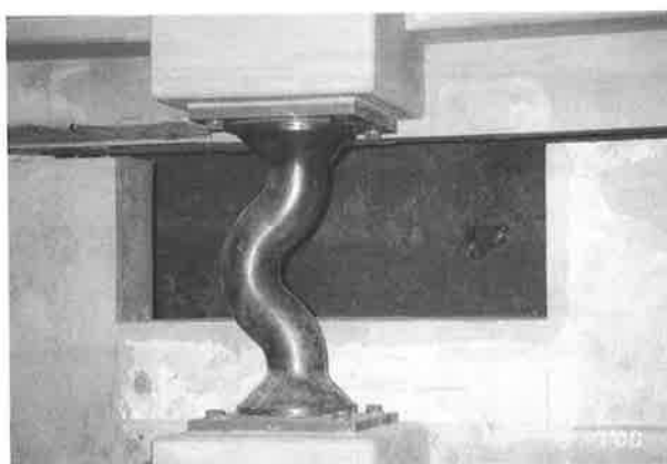
写真-5 設置された鉛ダンパー
