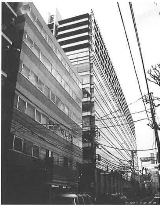
写真-5 建物外観
