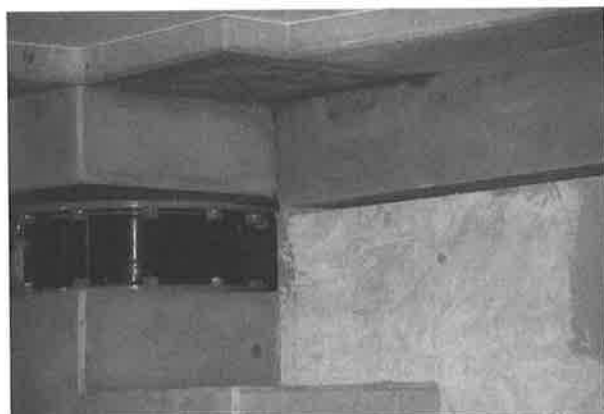
写真-4 ウォールソーで切断された壁
