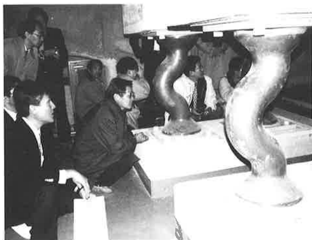
写真-1 免震ピット 鉛ダンパー設置状況
