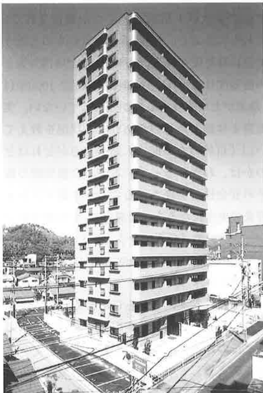
写真-1 建物外観
