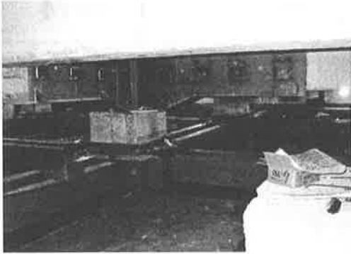
写真3 2階（免震階）床躯体新設状況
