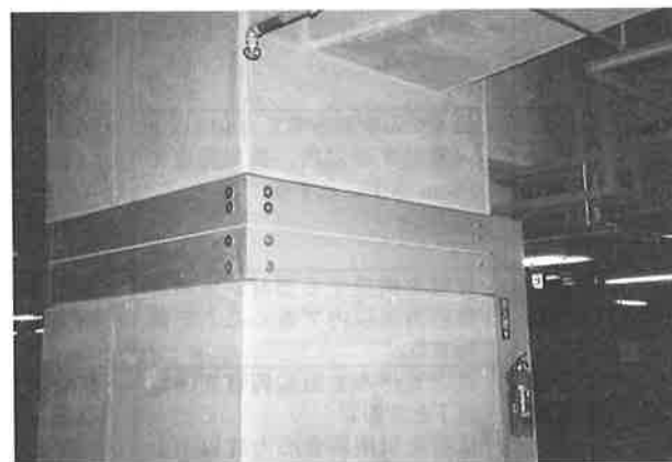
写真-2 地下1階中間層免震部
