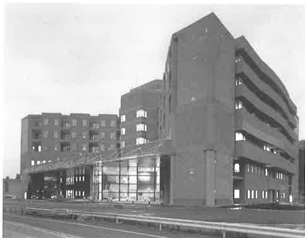
北西面からエントランスを見る
