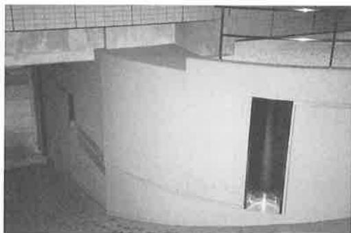
写真一4 車路進入部
