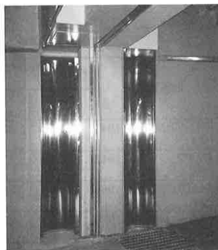
写真-3 地下1階シャッター部分
