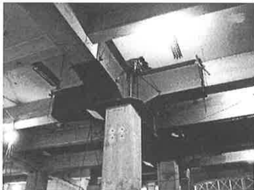
写真1 既存3階大梁補強状況
