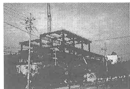
写真-2 鉄骨工事終了時全景
