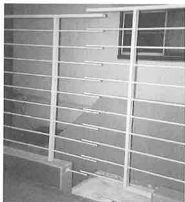
写真一7 手摺り部分
