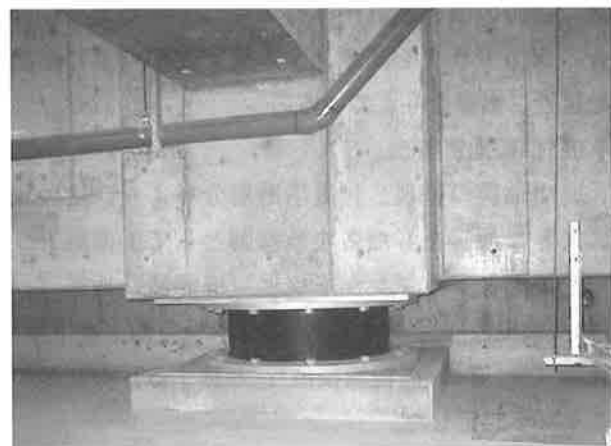
写真－2．免震装置設置状況
