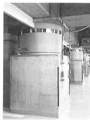
免震装置耐火被覆材 FIRE CATCH™
