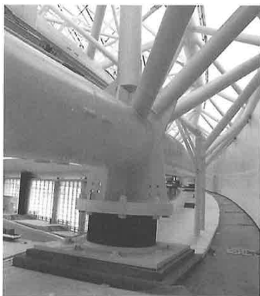
写真-4 積層ゴム支承とリングトラス
