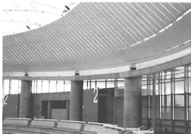
写真-5 独立柱と積層ゴム支承
