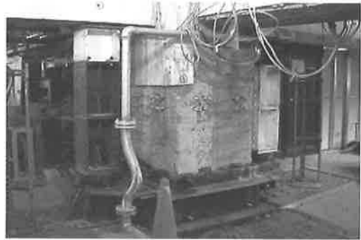
写真一七 仮受支柱設置状況
