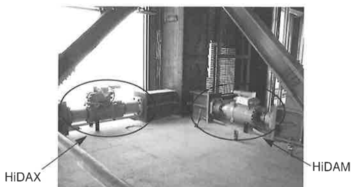
写真3-2 オイルダンパー設置状況
