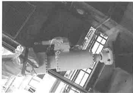
写真3-5 オイルダンパー設置状況2
