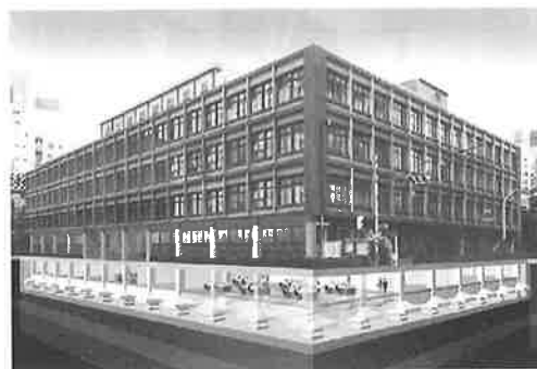
東京都豊島区役所本庁舎
