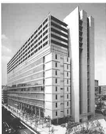
建物外観1 (写真撮影: SS東京)
