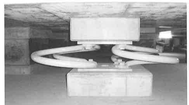
写真-3 鋼棒ダンパー
