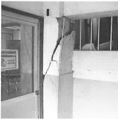
写真4 旧千厩中学校の柱のせん断破壊 (東北工業大学舟木尚己博士提供)
