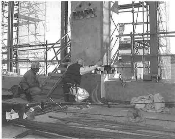
写真-3 柱設置状況
