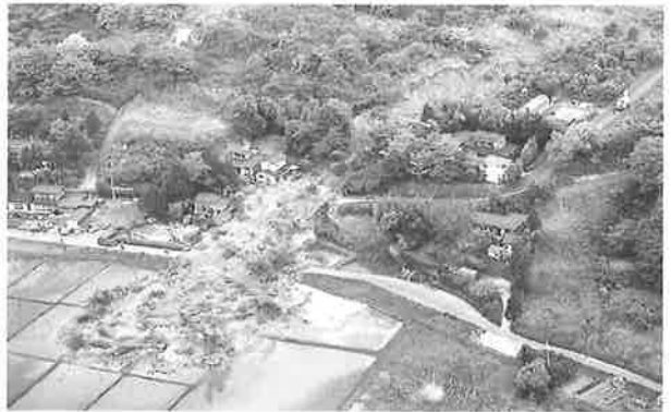
写真7 築館町の高速地滑り (株)ミヤギエンジニアリング提供)
