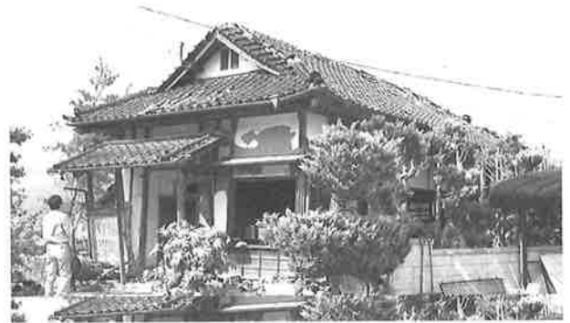
写真1 大船渡市で全壊した伝統木造住宅 (清水建設(株)和泉研究室提供)
