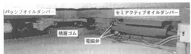
免震装置 (中央: 積層ゴム、左: パッシブオイルダンパー、 右: セミアクティブオイルダンパー)
