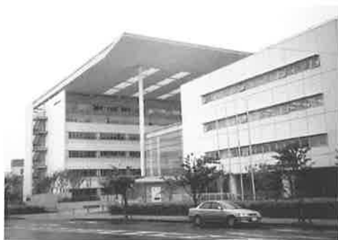
写真-1 建物全景
