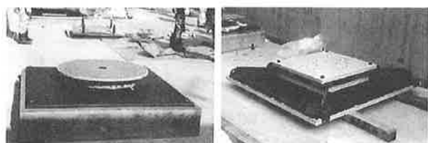
写真-1 “滑り支承” 取付け状況
