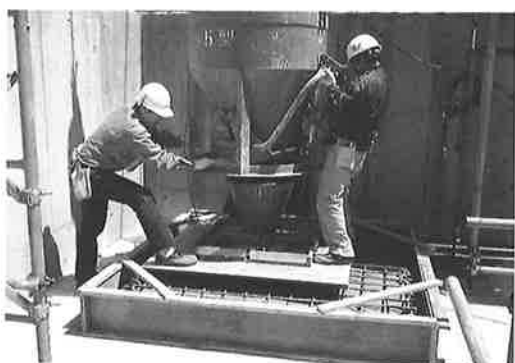
写真-7 ホッパーによるBP下部コンクリート充填
