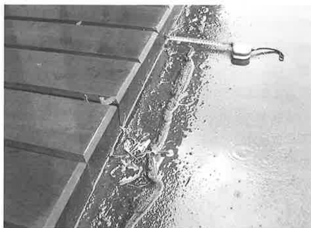
写真-8 免震建物が押し出した砂
