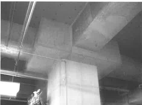
写真ー8 免震装置下の躯体
