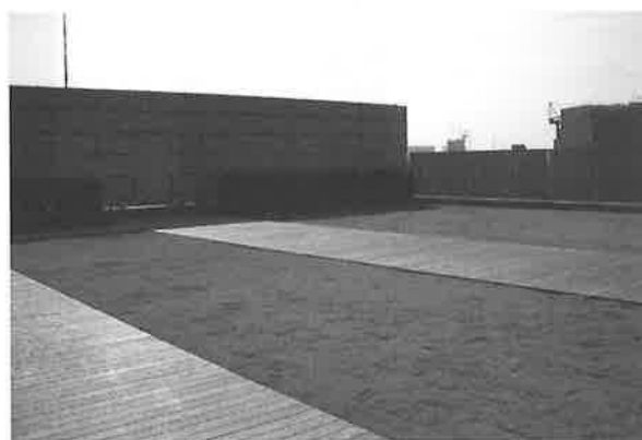
写真-4 屋上緑化
