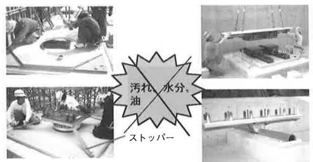
すべり支承の取り付け・養生
