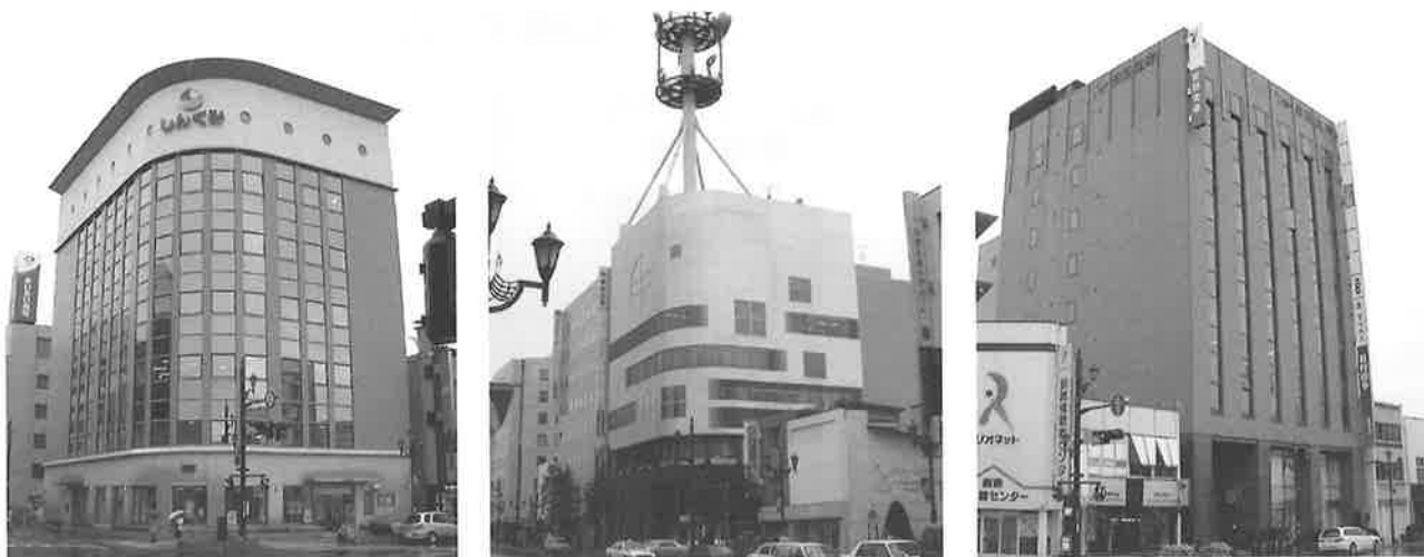
写真-2 釧路市北大通に面する免震建物 (左から順に、釧路商工信用組合、北大通り10丁目ビル、安田生命釧路ビル)
