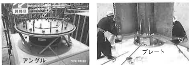
免震ゴムの変形拘束 写真-4 積層ゴム直上の鉄骨建方
