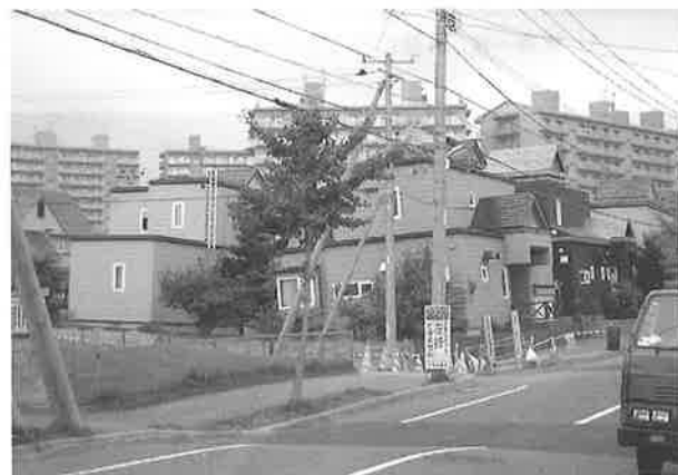
写真-10 札幌市内における地盤の液状化
