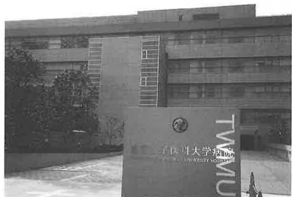
写真-1 建物外観
