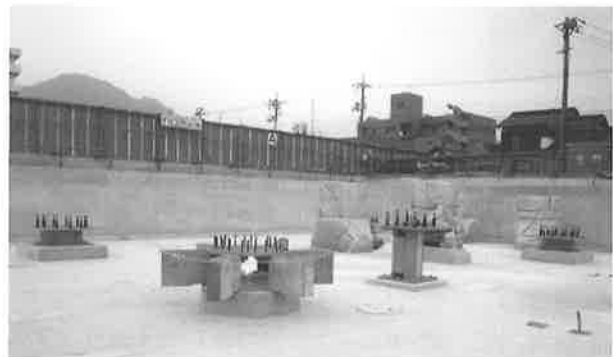
図-11 建物施工状況 (H15.9 現在)
