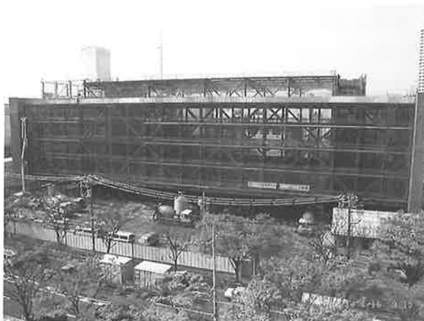
図-21 鉄骨建方終了時の状況
