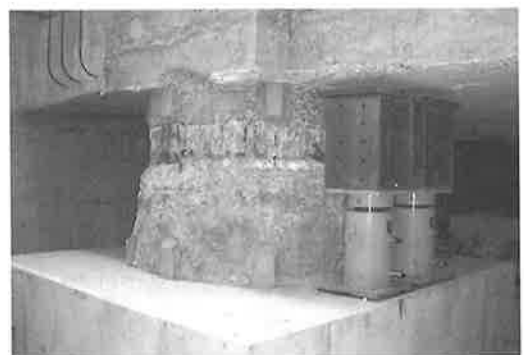
写真-2 既存杭の状況
