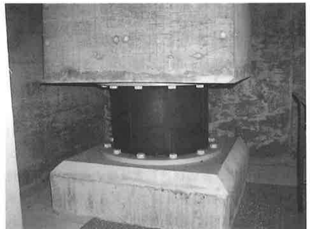
写真2.2 鉛プラグ入り積層ゴム
