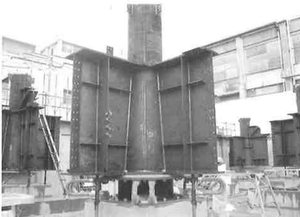
写真1 0節鉄骨建方状況
