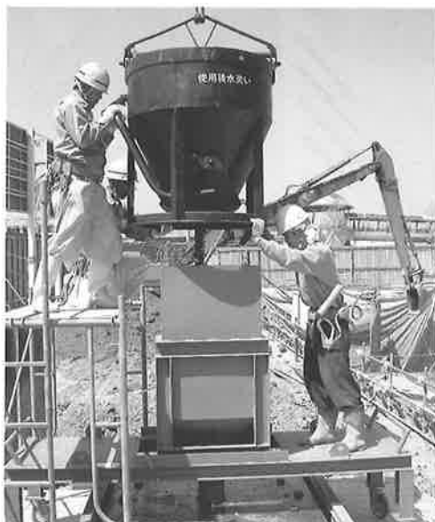
図-8 高流動コンクリート充填実験
