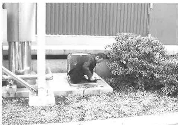
写真—6 免震層への入口
