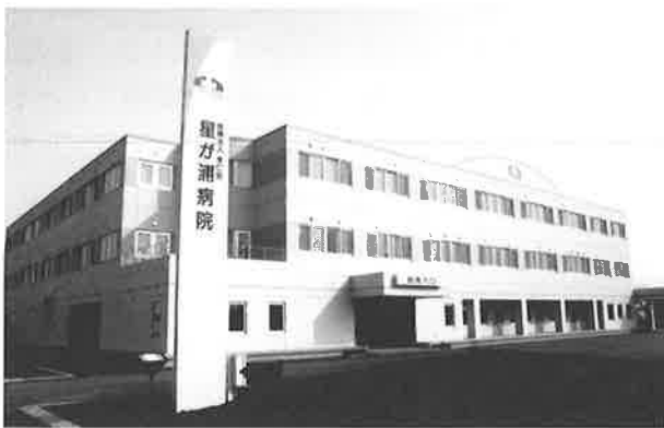
写真-1 建物外観
