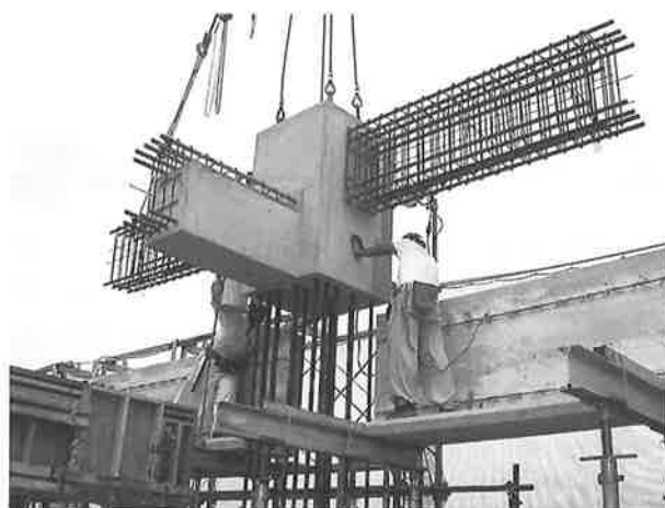
図-11 パネルゾーンPCa設置状況
