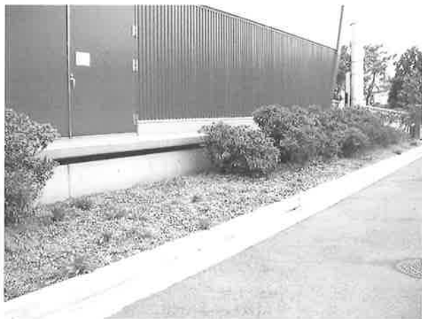
写真—5 建物外周の犬走り
