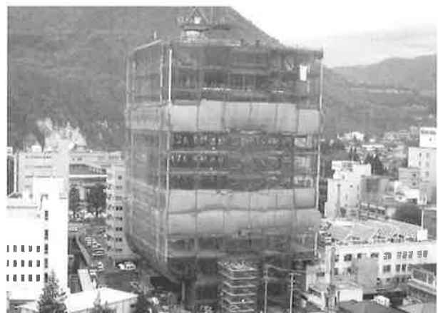
写真2 鉄骨上棟時外観（東面）
