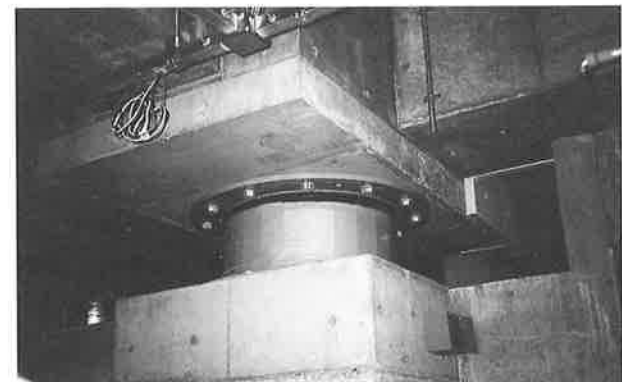
写真-4 免震部材設置状況
