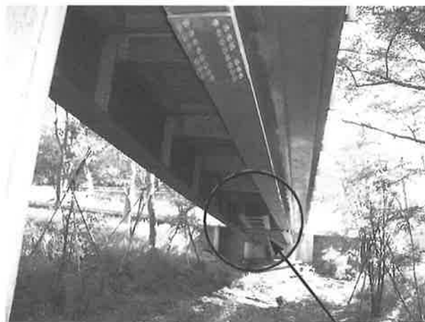
写真-5 アプローチブリッジとTMD
