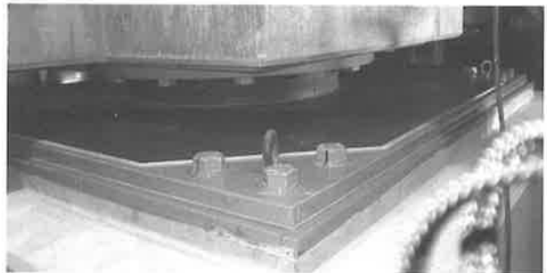
写真-3. 免震装置設置状況(SSR)
