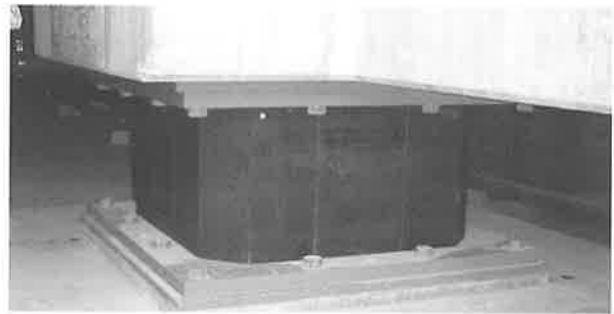
写真-2. 免震装置設置状況(LRB-S)
