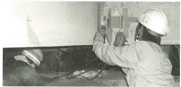
写真5 エポキシ樹脂の注入
