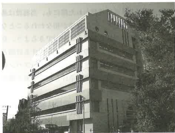
写真-1 建物外観
