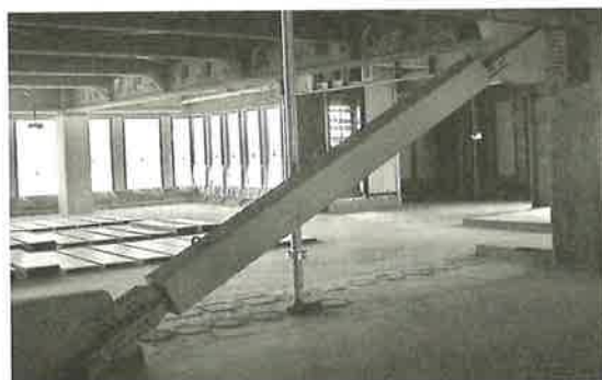
写真-3 アンボンドブレース設置状況
