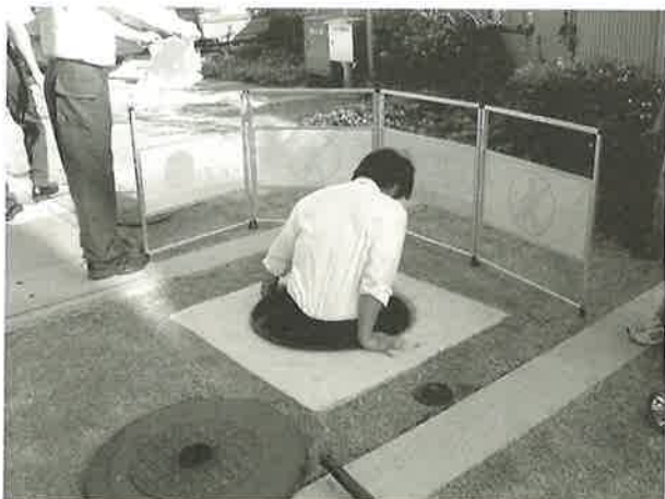
写真-10 免震ピット入口
