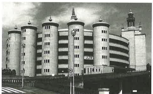
写真1 既存建物外観
