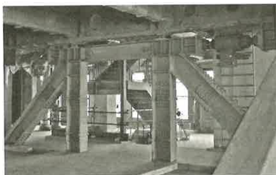
写真-2 セミアクティブダンパー設置状況
