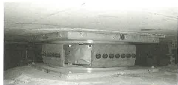
写真6 免震装置据付完了
