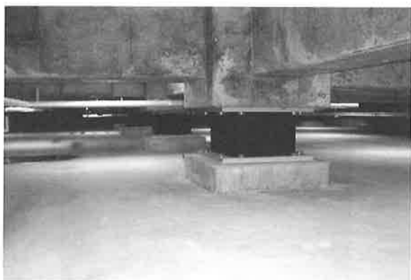
写真2 鉛プラグ入り積層ゴムLRB-S
