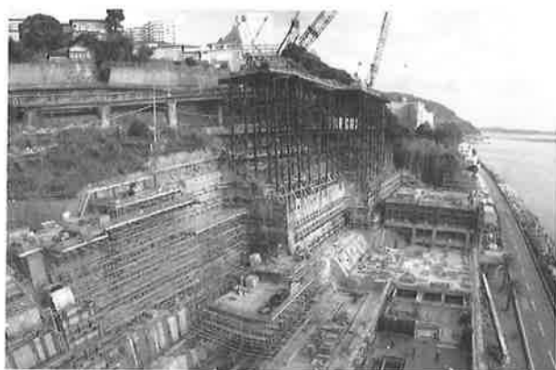
写真1 施工状況(平成16年3月)
