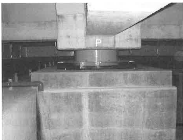
写真2-1 免震装置(弾性すべり支承)外観
