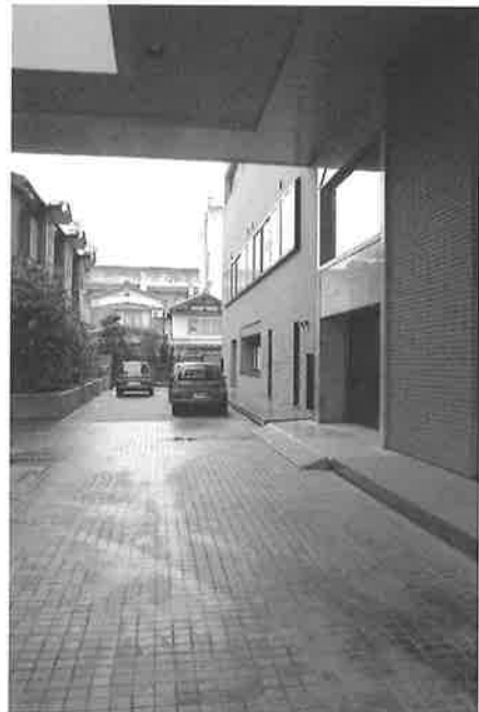
写真2 免震層外周部
