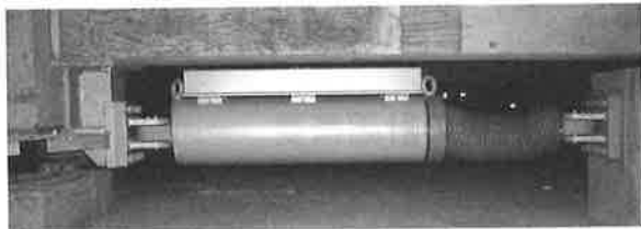
写真2 オイルダンパー
