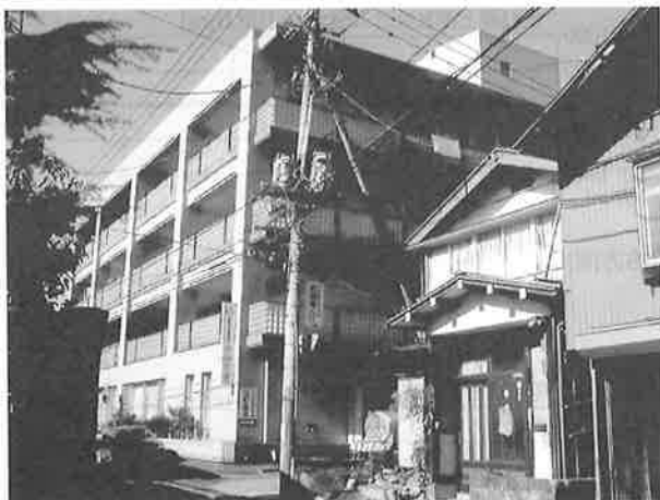
外壁クラックなど、地震による被害はない。
