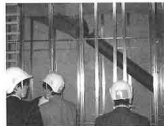
写真1 ダンパー設置状況
