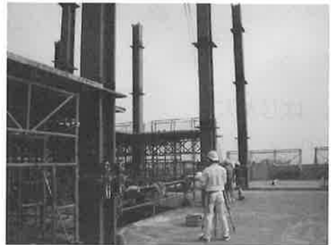
鉄骨柱建方とフライングジョア
