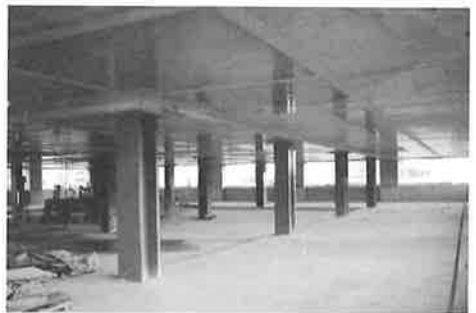
基準階躯体状況
