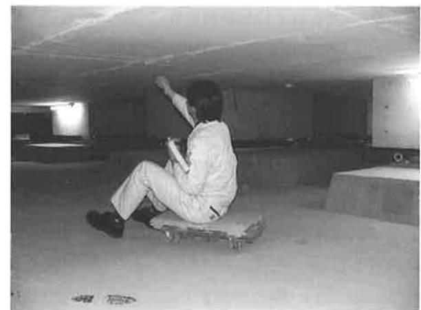
写真4 免震ピットメンテナンス状況
