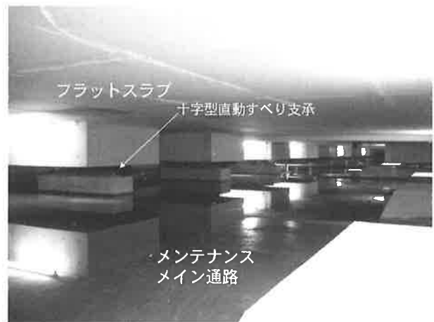
写真3 免震ピット内観
