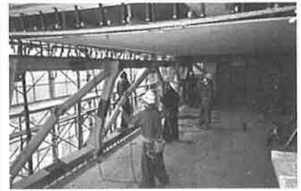
写真—9 建て込みの様子
