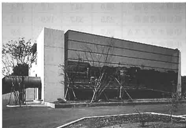
写真4.3 技研本館（非免震）
