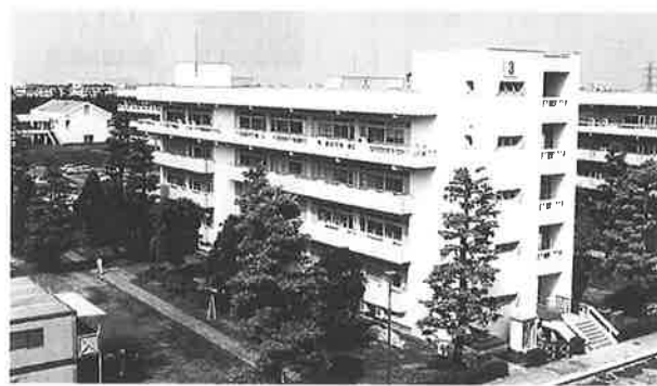
写真-3 建物外観 (3号館)
