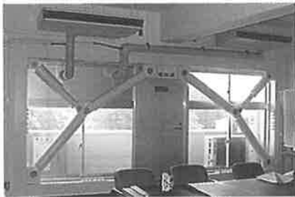
写真—7 非常用出入口部
