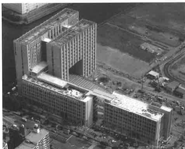
写真1 工事中写真(2005年9月現在)
