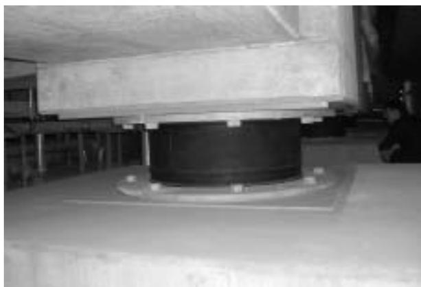
写真4 免震層の鉛入り積層ゴム
