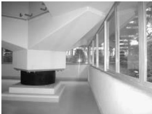
写真7 積層ゴム設置状況
