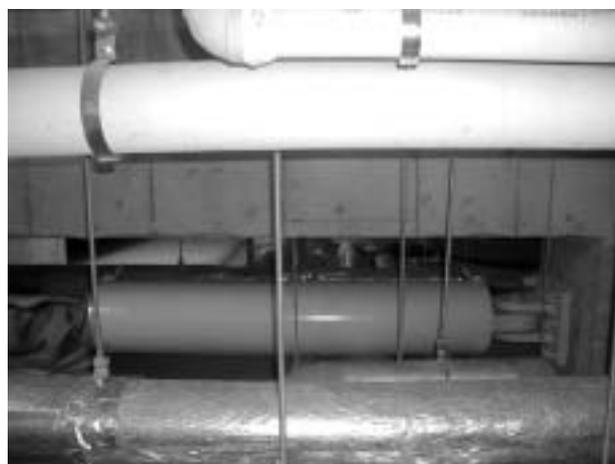
写真-9 オイルダンパーの設置状況
