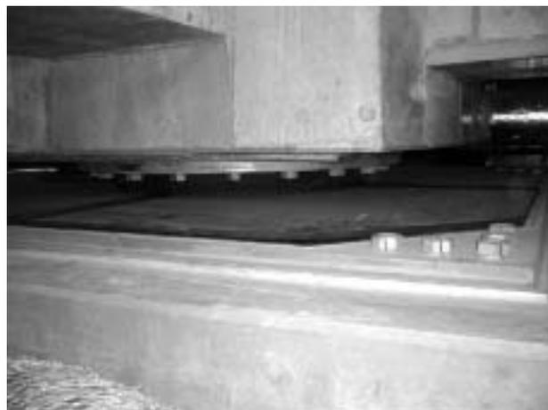
写真-7 弾性すべり支承の設置状況
