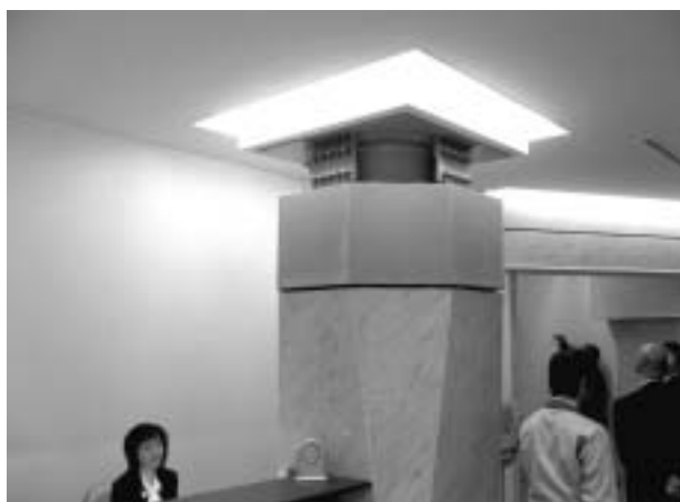
写真4 受付付近に設置された積層ゴム
