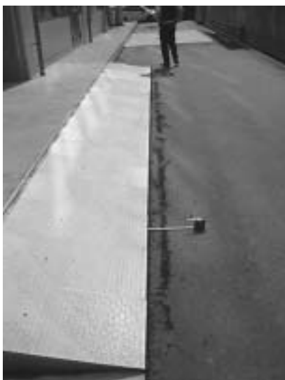
写真5 車輦出入部の免震EXP.J.
