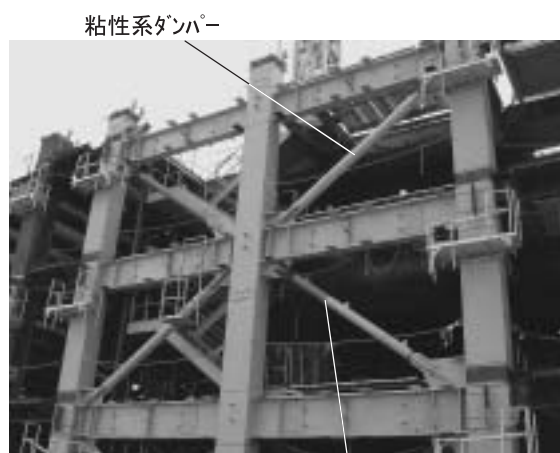
鋼材系ダンパー 写真2 短辺方向ダンパー
