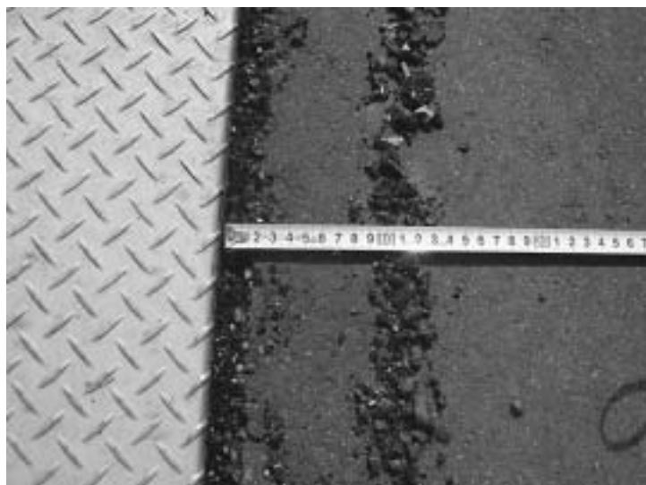
写真6 免震EXP.J.がアスファルトを削った跡
