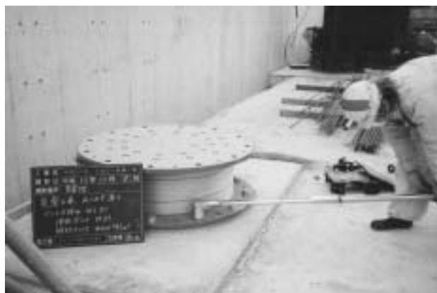
写真5 取り付けボルトのトルク管理
