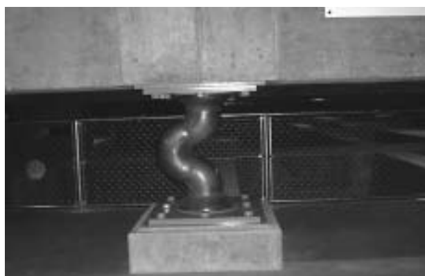
写真3 鉛ダンパーの状況(異常なし)
