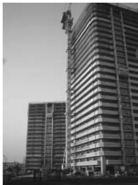
写真3 高層免震建物+マストクライミング型タワークレーン
