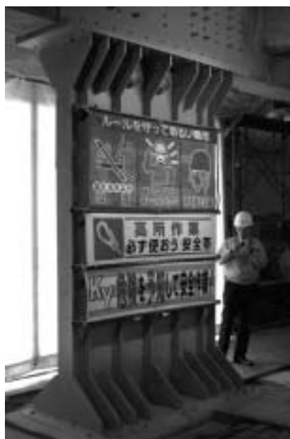
写真2 仮設鋼材ダンパー
