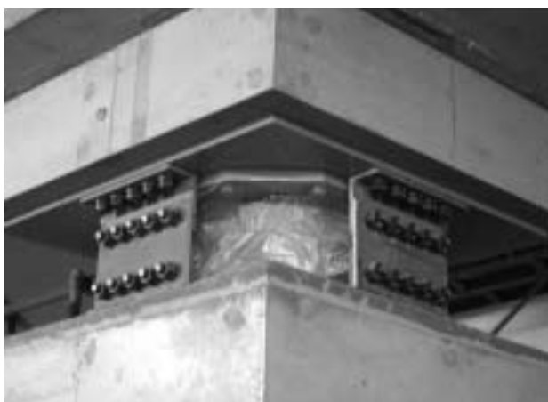
写真3 仮設補強された積層ゴム
