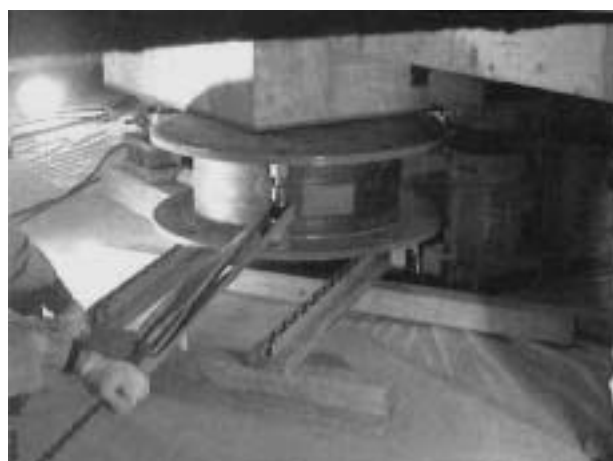
写真10 積層ゴムアイソレータの取替え実施例
