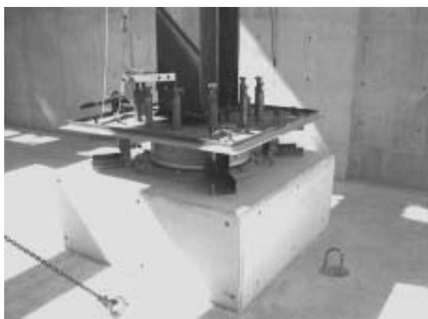
写真1 積層ゴム直上の鉄骨建方の場合
