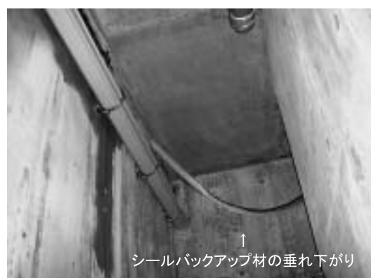
写真4 鉛直クリアランス部のシール切れ
