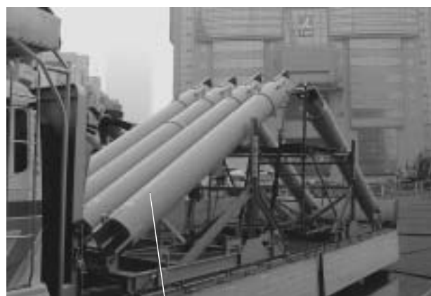
水平にすると粘性体が流れ出るため斜め輸送 写真3 粘性体ダンパー
