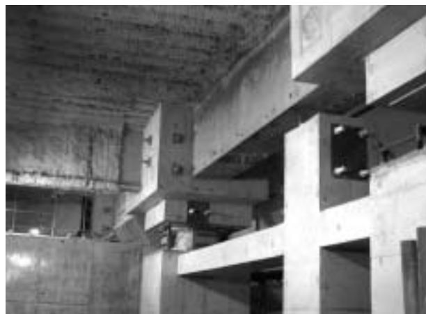
写真1 オイルダンパー設置用フレーム
