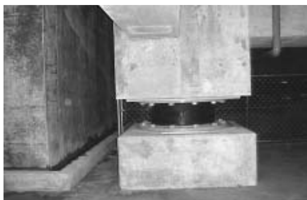
写真2 積層ゴムの状況(異常なし)
