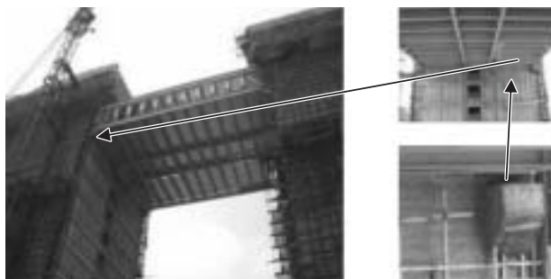
図7 連結ビルに使用した免ゴム支承(広州市)
