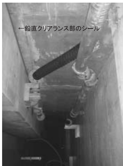
写真8 鉛直クリアランス部のシール状況 (免震層内部：異常なし)
