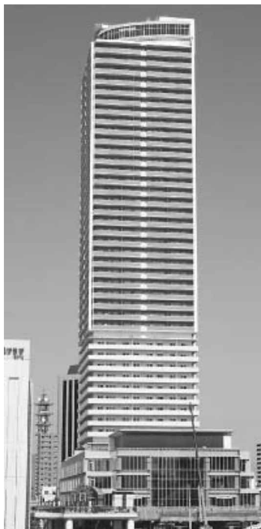
図1 建物外観写真
