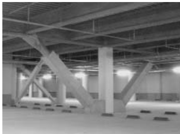
写真6 RC被覆アンボンドブレース
