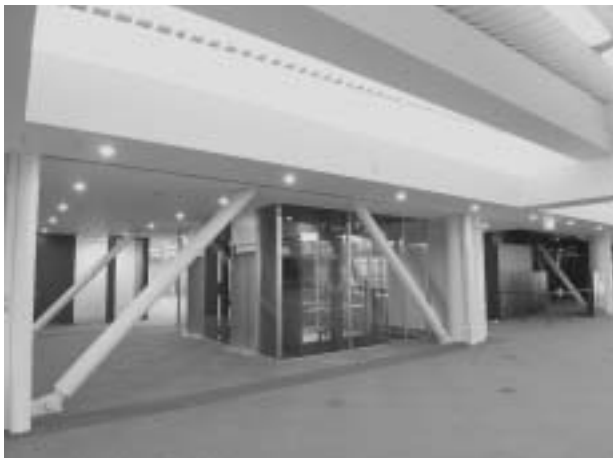
写真7 二重鋼管座屈補剛ブレース
