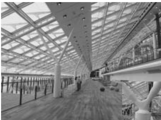
写真8 建物内観 (Y字柱、鋳鋼)
