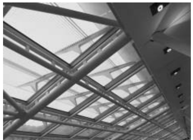
写真9 建物内観 (ガラス屋根、ルーバー)
