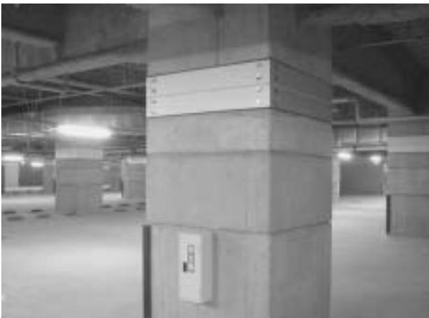
写真10 免震装置(柱頭免震、耐火被覆)
