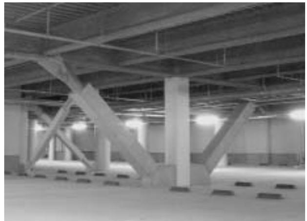
写真6 RC被覆アンボンドブレース
