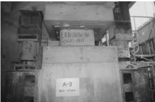
写真3 1階柱に取り付けられた積層ゴム
