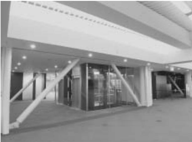
写真7 二重鋼管座屈補剛ブレース
