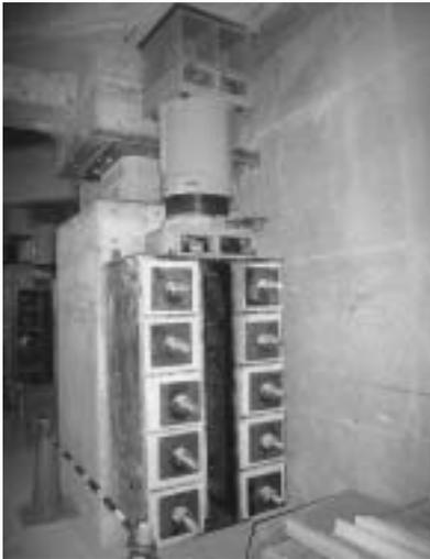
写真2 1階柱に取り付けられた鉄骨補強治具
