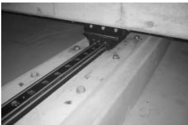
写真6 直動転がり支承交差型免震部材(20基)
