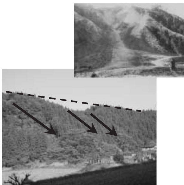
写真4 崩れの様子(当時)と山崩れ跡らしき地形
