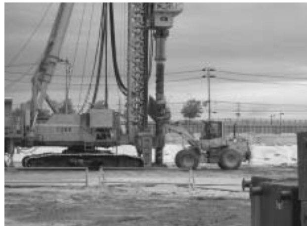
図6 砂杭による地盤改良工事の様子
