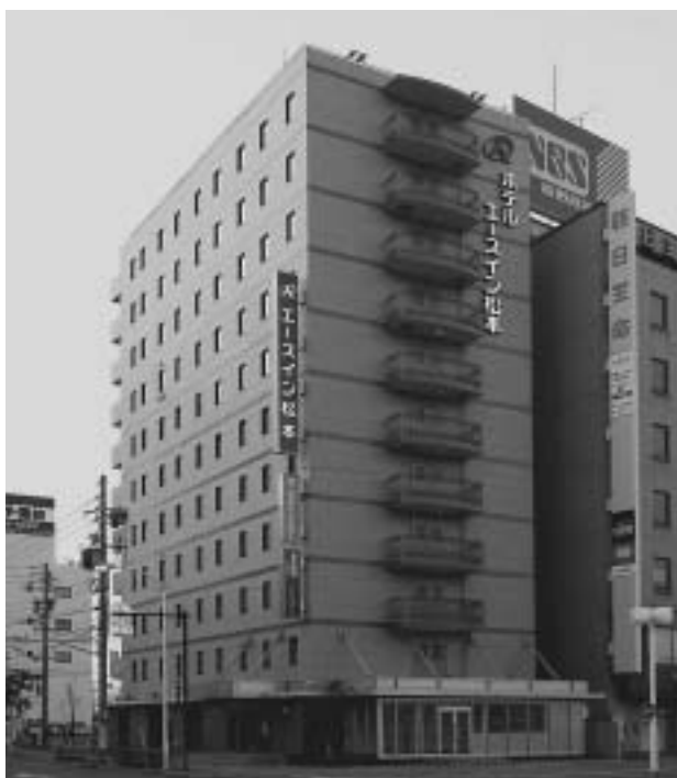
写真1 建物外観（改修後）
