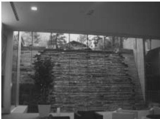
写真2 擁壁を利用した流水壁
