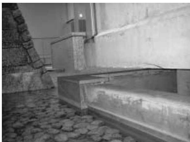
写真7 免震層と水路の状況
