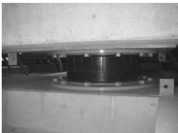
写真5 鉛プラグ入り積層ゴム
