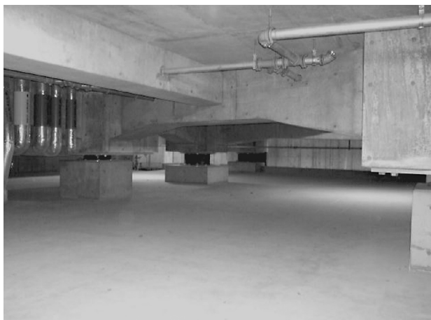
写真7 免震層の状況
