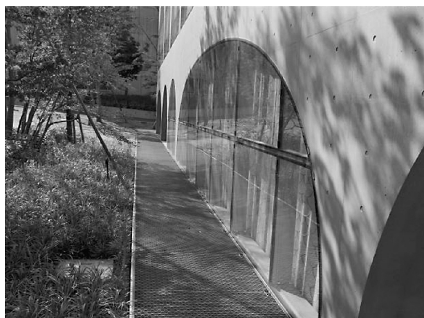
写真9 外部の免震クリアランス部分
