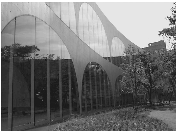
写真10 北面(正面)の曲線外壁
