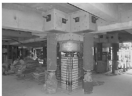
免震支承取付
