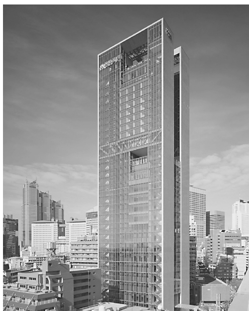
写真1 全景写真(南面)
