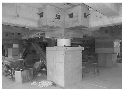
柱周り補強後
