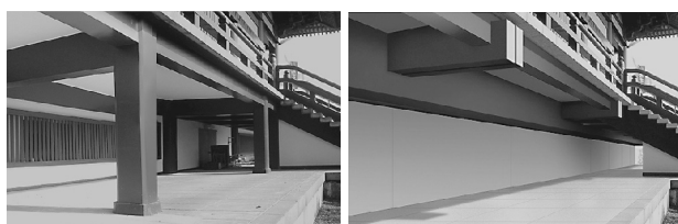
図5 側面外観(左:改修前/右:改修後)
