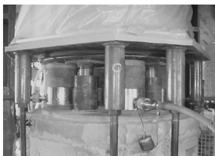
プレロードジャッキ・プレロードケース設置
