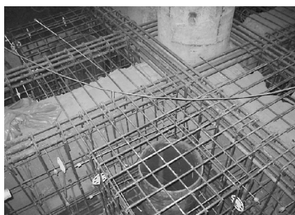
基礎つなぎ梁補強配筋
