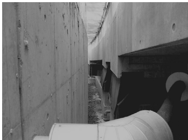
写真8 内部の免震クリアランス部分
