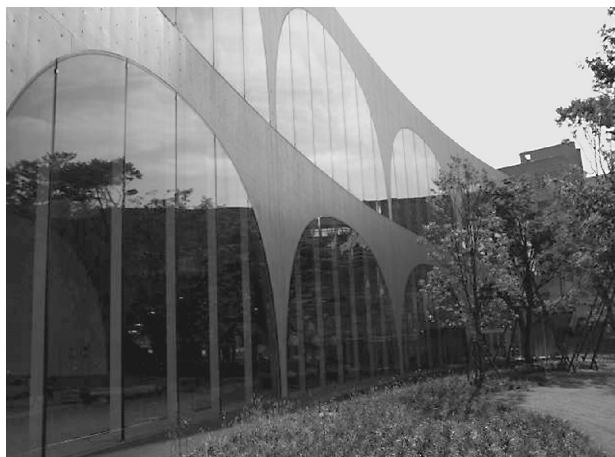
写真10 北面(正面)の曲線外壁
