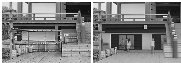
図4 正面外観(左:改修前/右:改修後)
