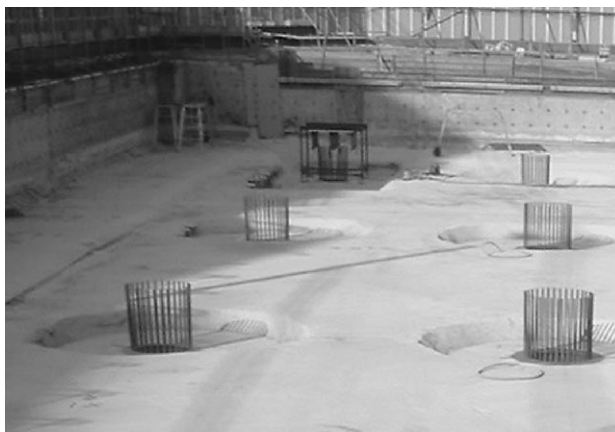
写真3 P/Rパイルの設置状況
