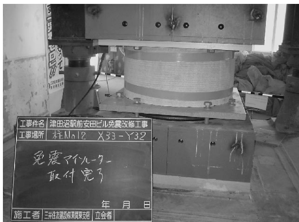
写真3 積層ゴム据付状況
