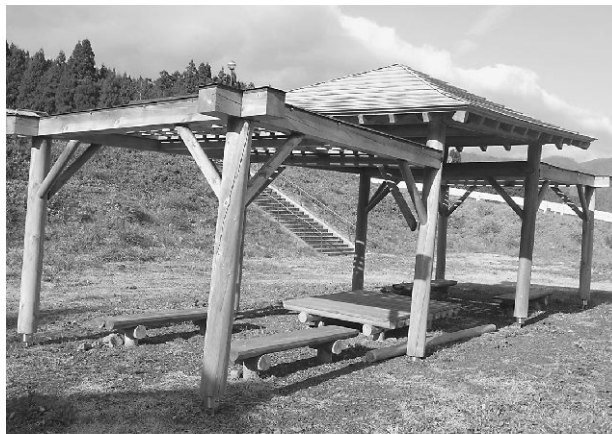
写真13 観測小屋近くの休憩所
