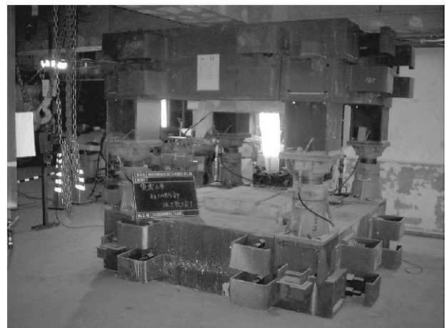
写真2 柱切断後状況
