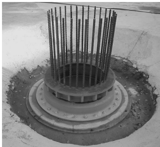
写真2 P/Rパイル工法PA型支承
