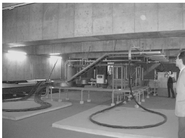
写真9 免震層見学風景
