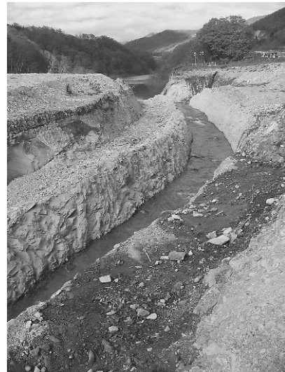
写真18 堰止湖の排水路
