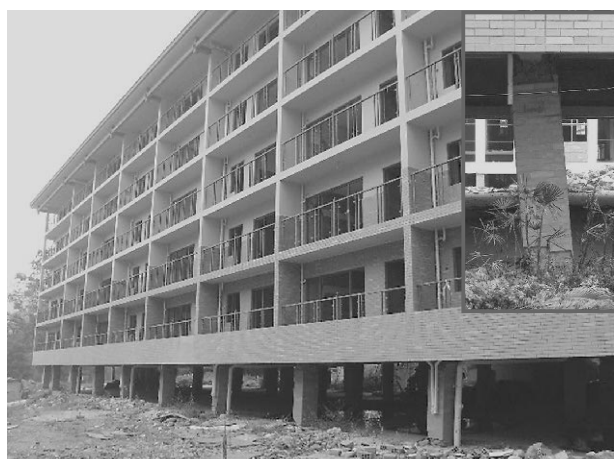
写真 復旧工法の議論のために選定した例題建物（都江堰市の6階建てRC造集合住宅）
