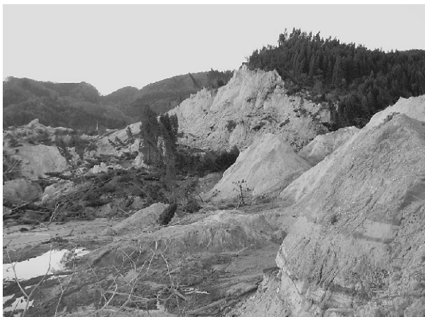
写真7 荒砥沢ダムの山体崩壊の状況
