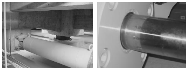
写真1 栗原中央病院 免震装置写真 （左：免震装置 右：オイルダンパー摺動痕）
