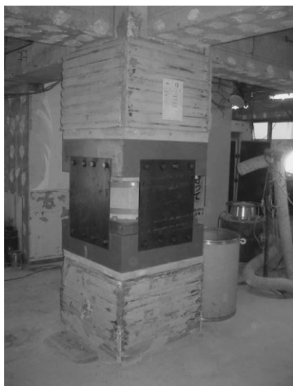
写真5 柱免震化工事完了状況
