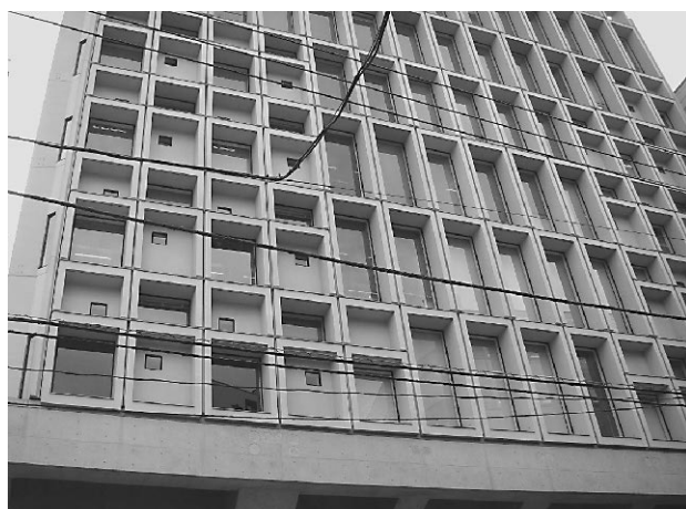
写真8 ファサードの外壁耐震壁
