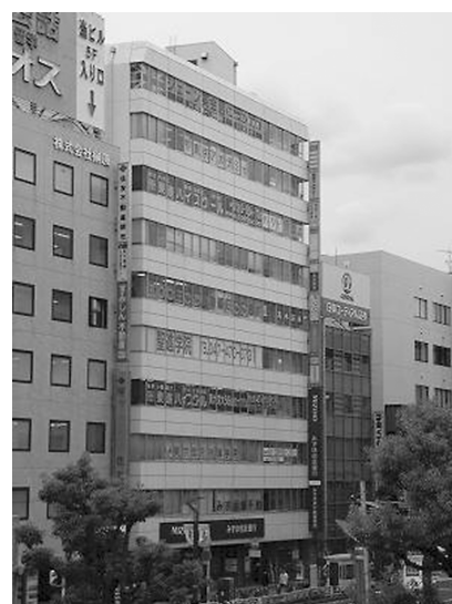
写真1 既存建物外観
