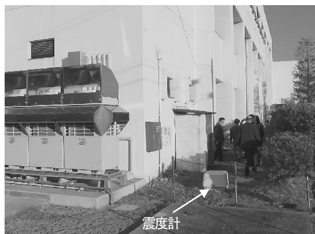
写真5 一迫総合支所の震度計とその周辺状況
