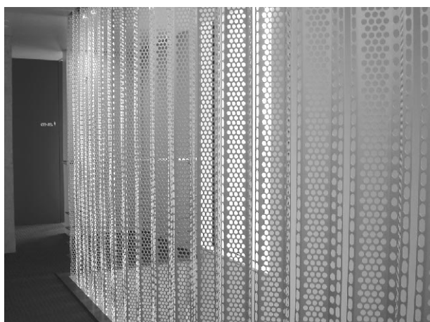
写真5 階段室スクリーン(有孔切板)
