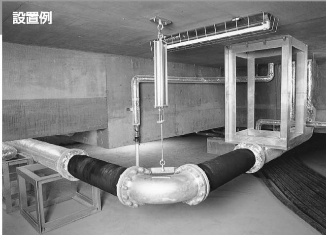
免震構造は、積層ゴムによってビルを地盤から切り離し、地震のエネルギーを直接ビルに伝えません。しかし、それだけでは、ビルと地盤の相対変位によりライフラインは寸断されてしまいます。ライフラインを守るためには、大きな変位吸収が可能なフレキシブルジョイントが必要不可欠です。免震サプレックスは、免震積層ゴムメーカーが提供する免震用フレキシブルジョイントであり、地震の揺れを柔軟に吸収し、ビルのライフラインの安全を確保します。そして、この「免震サプレックス」は、免震積層ゴムと同様、国内の厳しい試験・検査・品質管理により皆様の生活を支えています。
