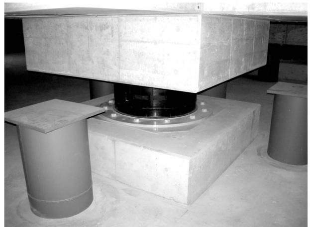
写真3 (2) 直接基礎部分の免震層
