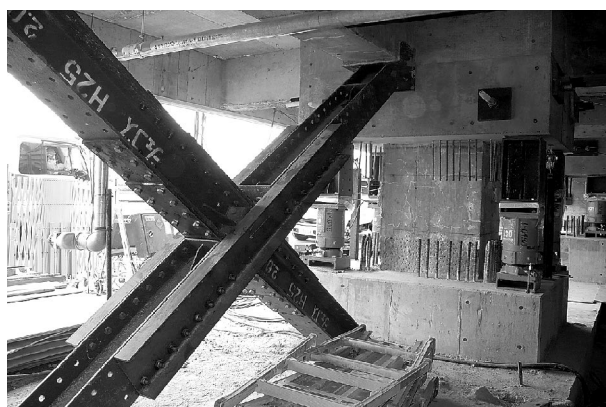
写真7 仮設耐震ブレース
