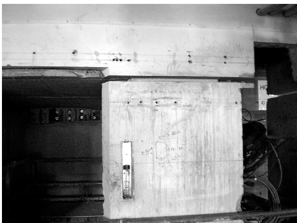
写真10 階段室RC壁の施工状況
