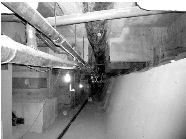
写真8 耐震構造部分との境界部分
