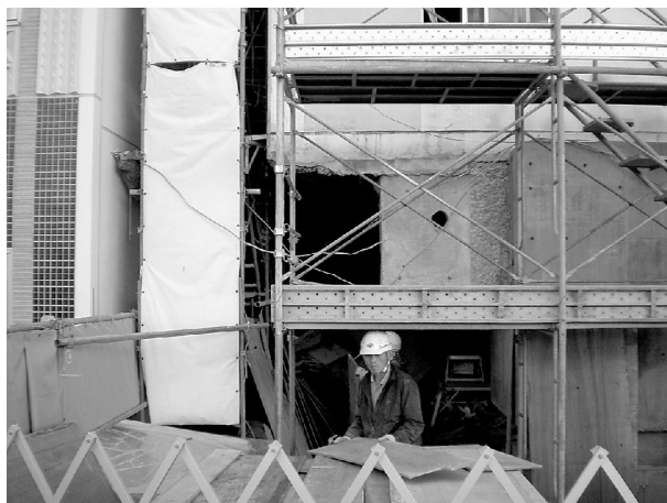
写真11 棟間部分施工状況
