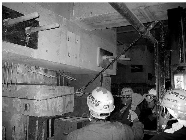
写真3 柱切断部取り除き
