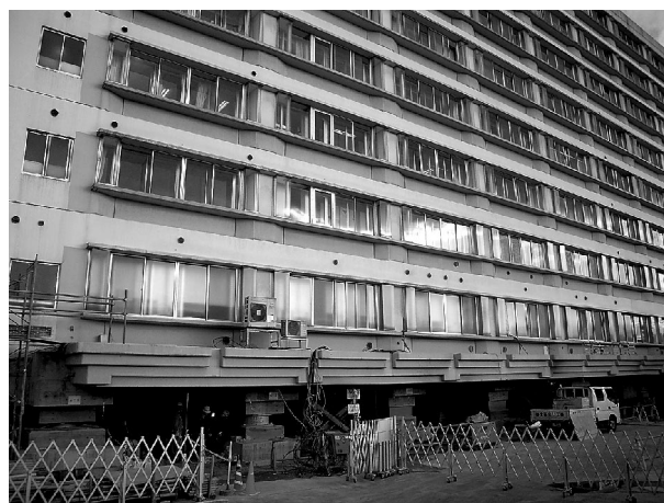
写真2 居ながらの改修状況(病室に灯りが見える)
