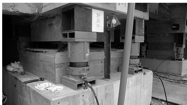
写真6 弾性滑り支承部分ジャッキダウン完了後状況
