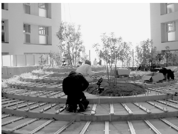
写真3 スカイガーデントラス上部
