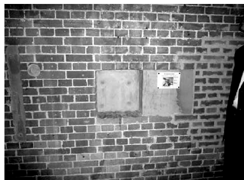
写真6 レンガ壁の原位置加力試験箇所
