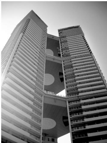
写真1 アイランドタワースカイクラブ(連結免制震)外観
