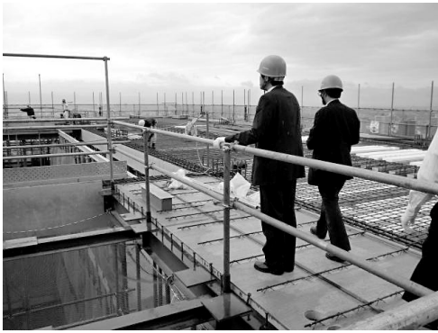
写真2 躯体施工状況
