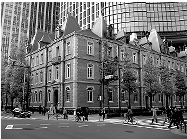
写真1 復元された建物全景
