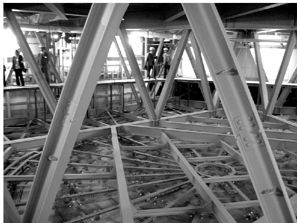
写真4 スカイガーデントラス内部見学風景
