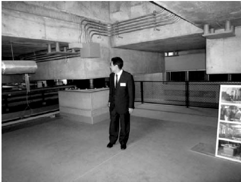
写真7 免震ピットの見学
