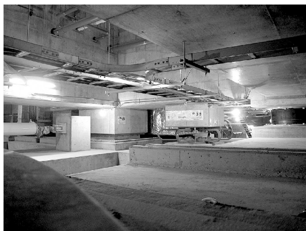
写真6 免震層内の装置設置状況
