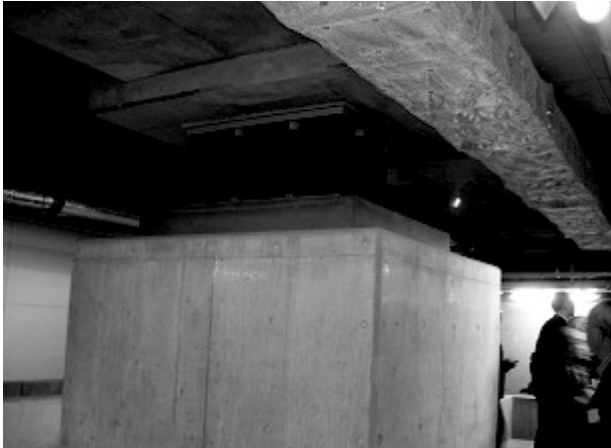
写真5 免震層の見学の様子(1)
