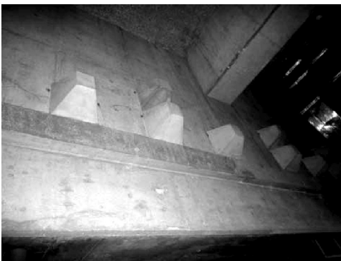
写真8 PC鋼棒による補強部
