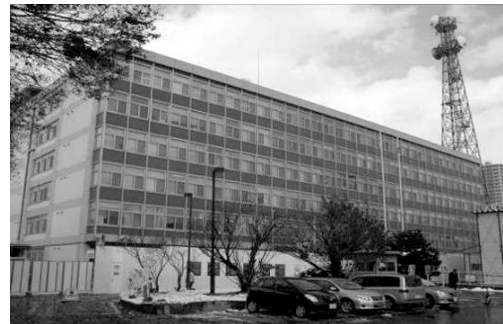
写真2 札幌開発総合庁舎(庁舎免震レトロフィット)外観
