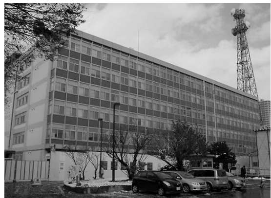
写真1 札幌開発総合庁舎
