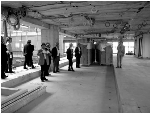
写真3 住戸内施工状況
