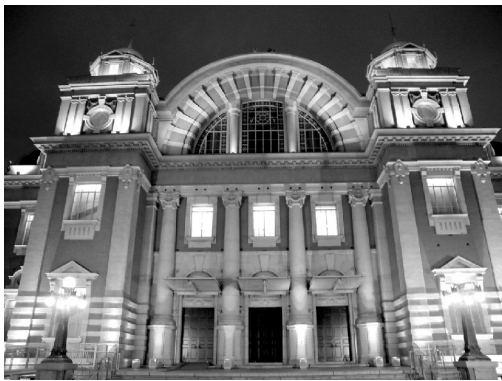
写真5 大阪市中央公会堂(レンガ造免震レトロフィット)外観
