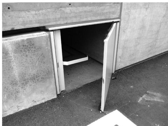
写真8 段差可動部の仕上げ処理(動いたとき)
