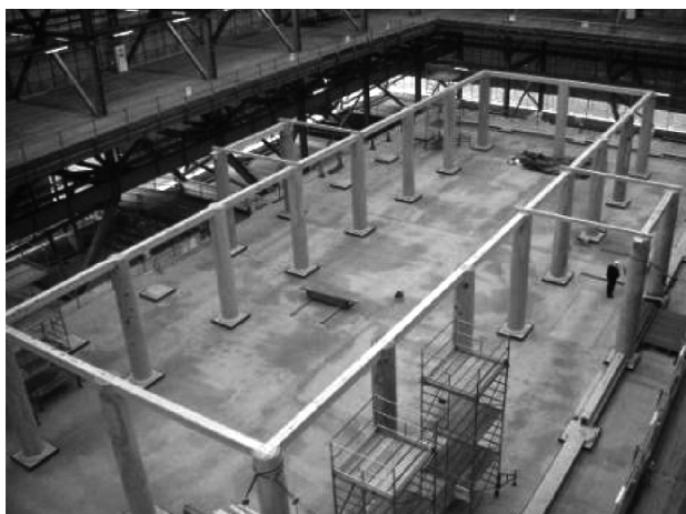
写真3 初重柱の施工状況
