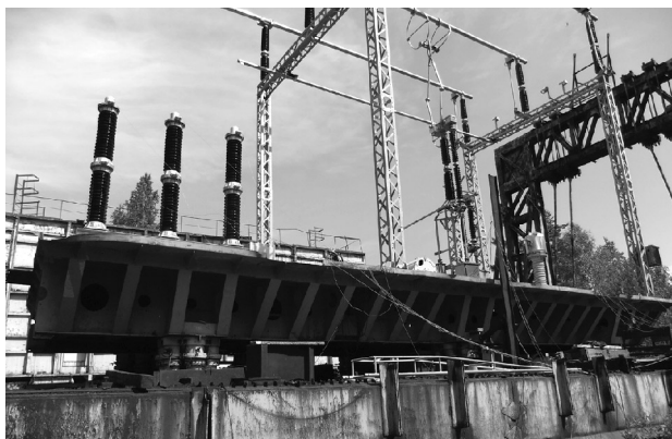
写真7 高圧送電線設備の試験
