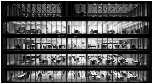
写真3 前面道路側のロングスパン架構 (撮影：野口兼史)
