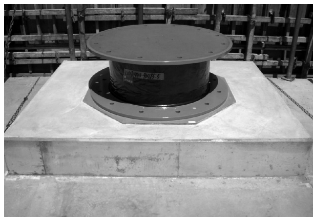
写真3 LRB 設置状況
