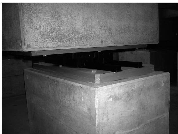
写真10 リニアスライダの設置状況
