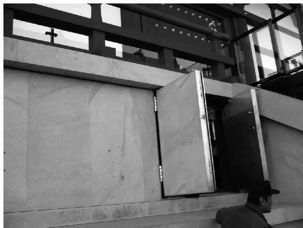
写真8 免震層への出入り口
