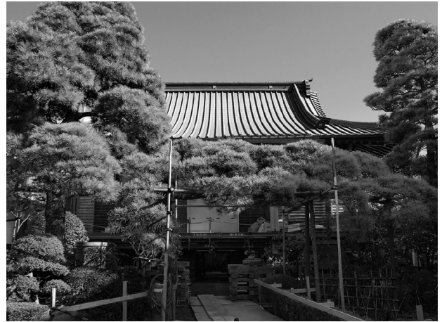
本妙院の工事の様子
