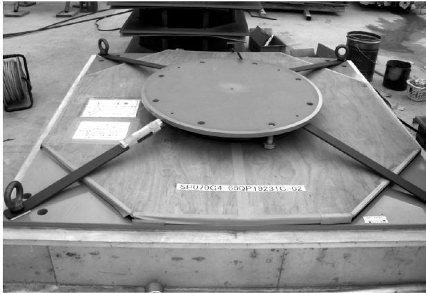
写真4 すべり支承設置状況
