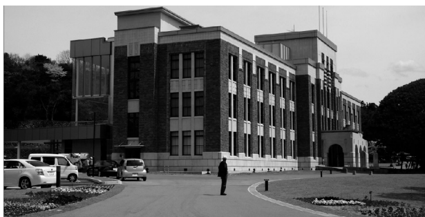
写真1 ガラスが増築部、タイルが保存部
