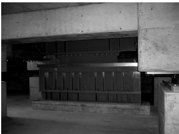
写真12 壁型粘性体ダンパー
