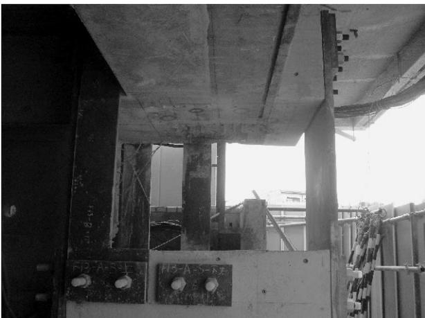
写真3 既存柱切断時の様子
