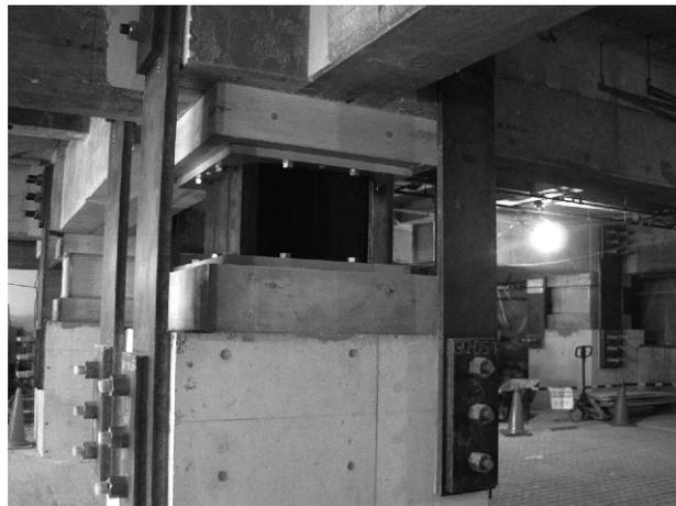
写真4 免震装置の設置状況
