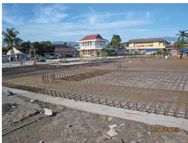
写真7 No.2建物現場写真 2011.6.6 マットスラブ（厚300mm）配筋状況
