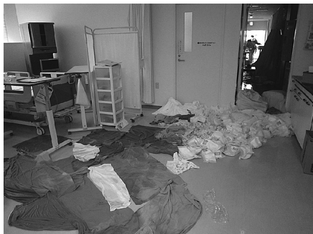
写真12 C棟（耐震建物）の給水管の破裂 2)
