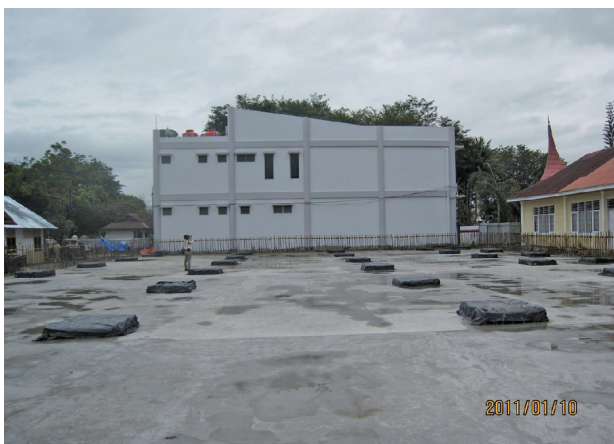
写真6 No.1建物現場写真 2011.1.10
