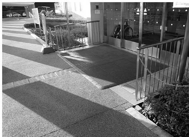
写真5 外来棟エントランス部の可動床
