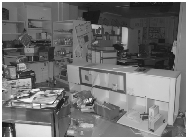
写真14 C棟（耐震建物）の倒壊した処置室の戸棚 2)
