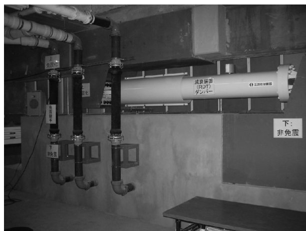
写真3 粘性減衰装置と免震継手
