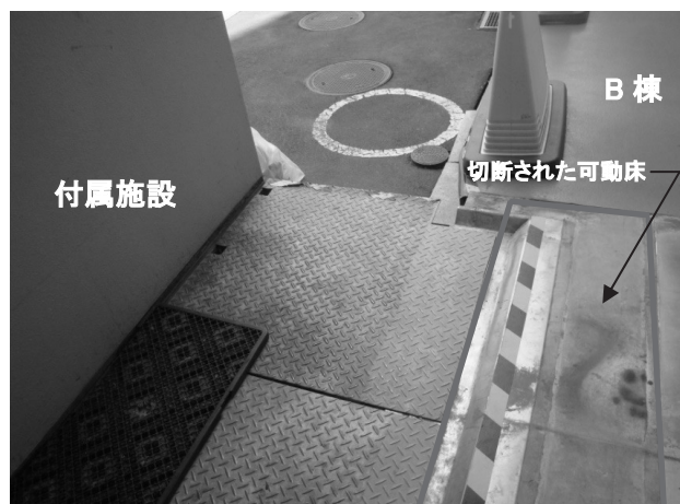
写真10 免震エキスパンション部（床）の状態（5/2）
