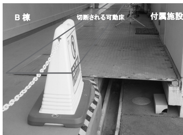
写真9 免震エキスパンション部（床）の状態（3/28）
