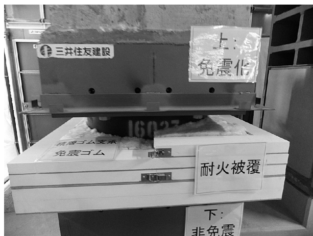
写真2 積層ゴム系免震装置設置状況
