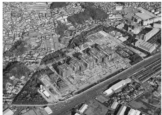
図14 施工状況写真
