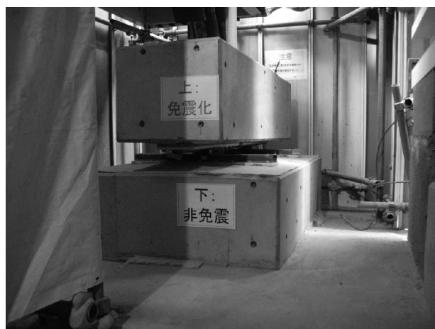
写真4 階段下の転がり支承
