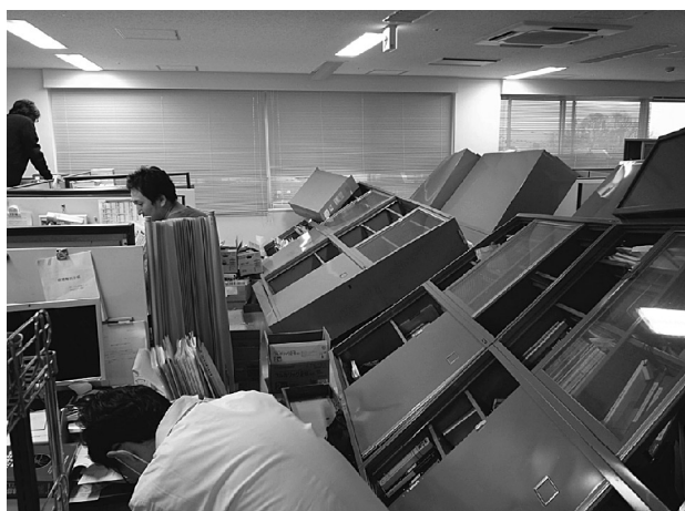
写真15 C棟（耐震建物）の医局のラックの転倒 2)
