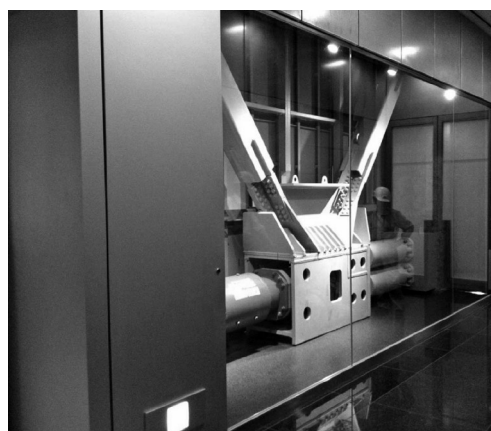
図12 制振ユニット取付状況
