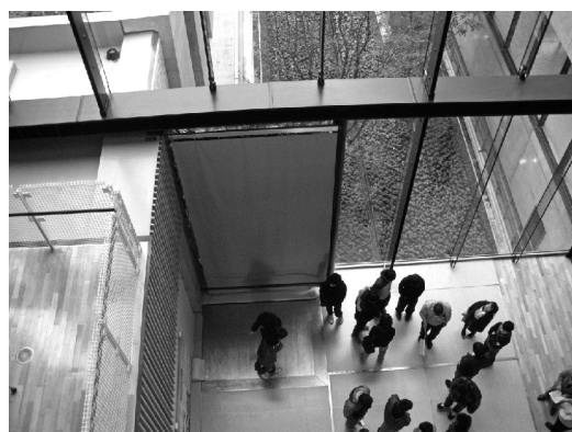
写真7 床エキスパンション
