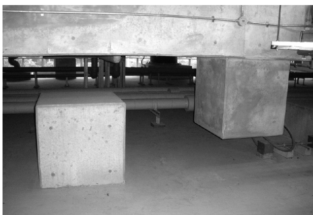
写真9 反力壁（ジャッキ設置）
