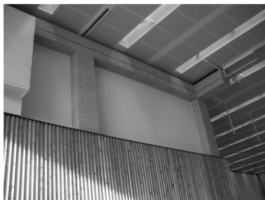
写真4 屋根のエキスパンション
