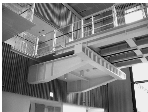
写真5 ブリッジのエキスパンション
