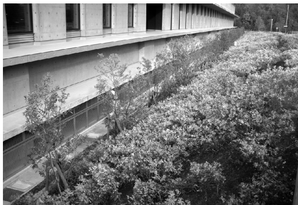
写真10 建物外周部の法面
