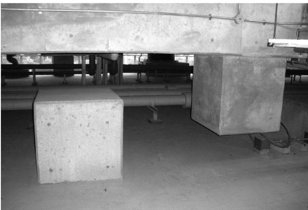
写真9 反力壁（ジャッキ設置）
