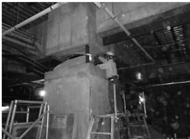
写真2 免震装置取付け状況
