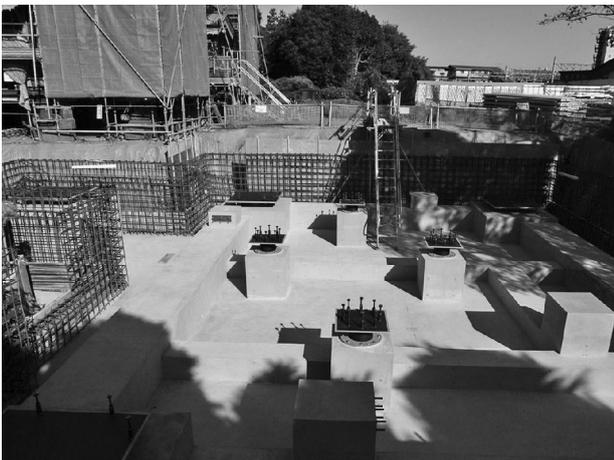
写真4 免震ピット施工状況
