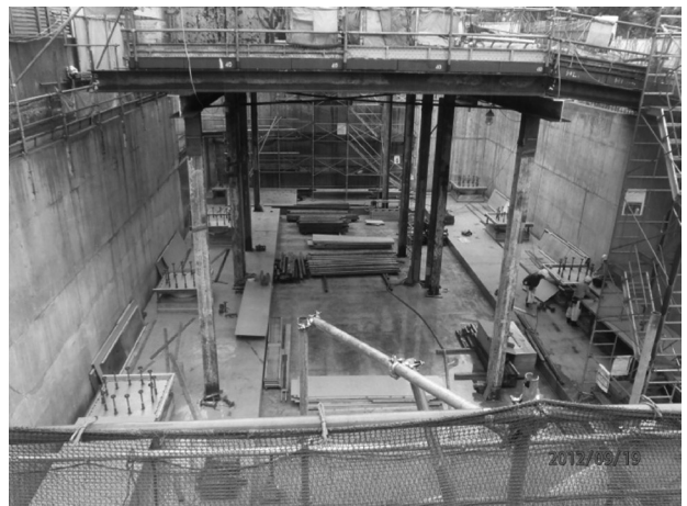
写真3 免震層の施工状況
