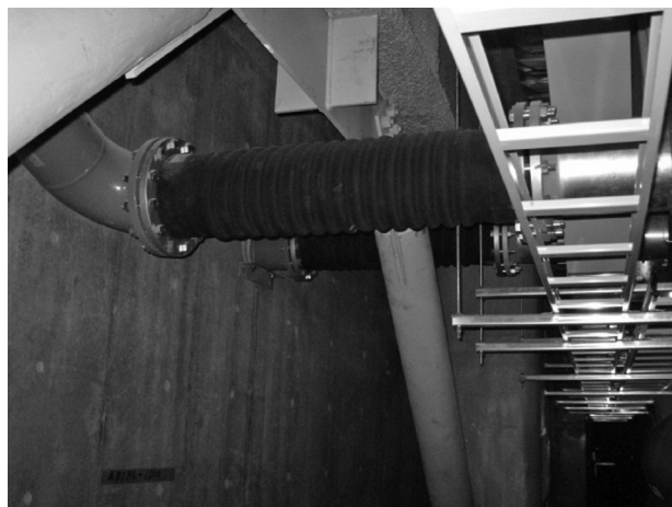
写真1 設備配管の取付状況
