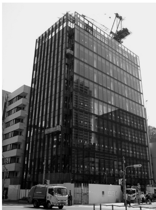
写真8 訪問時の建物外観
