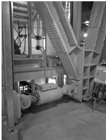
写真3 オイルダンパー取付状況
