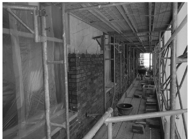
写真4 煉瓦中空積施工状況
