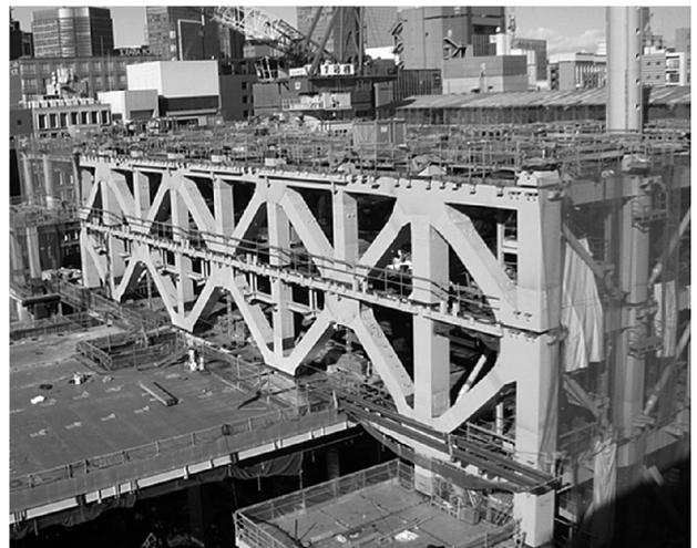
写真2 メガトラス建方完了時
