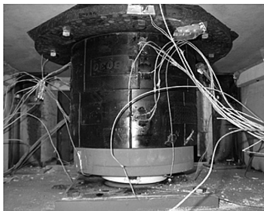
写真3 試験後すべり支承状況
