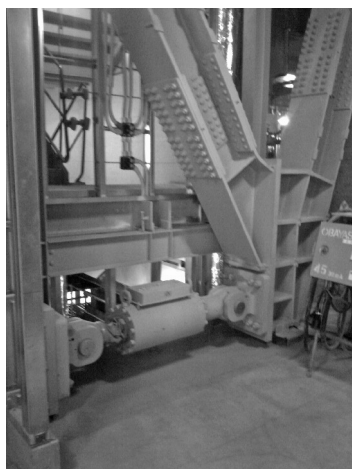
写真3 オイルダンパー取付状況
