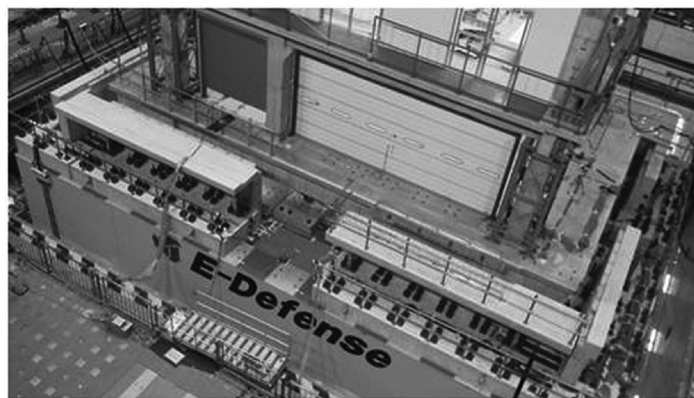
写真3 試験前の擁壁部
