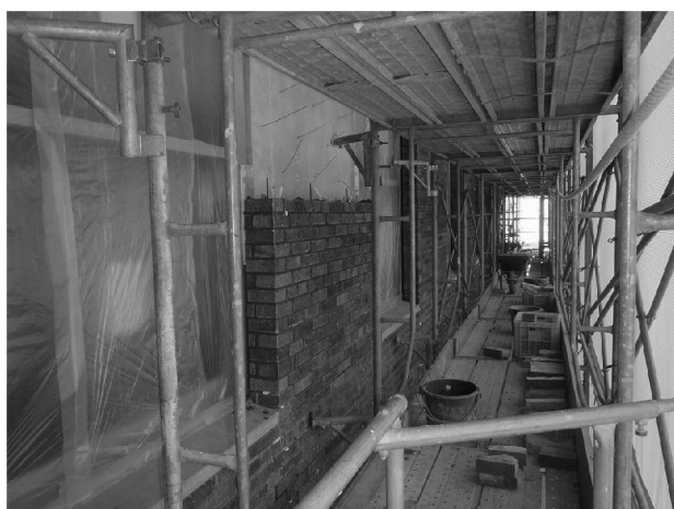
写真4 煉瓦中空積施工状況
