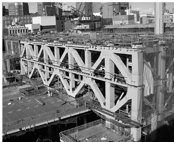
写真2 メガトラス建方完了時
