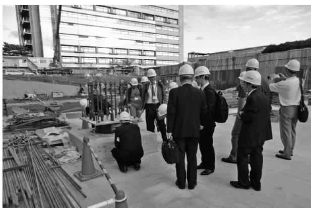
写真12 人間環境系実験研究棟の現場見学
