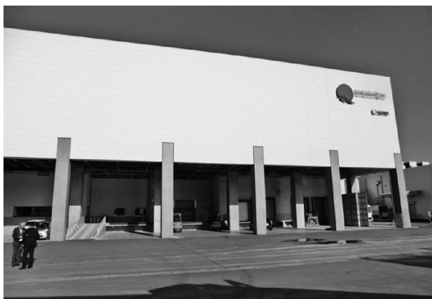
写真14 津波対策ビル「マスカー」の見学
