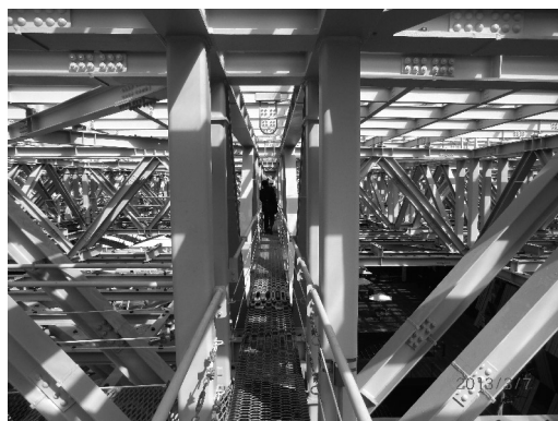
写真3 アリーナ棟鉄骨屋根
