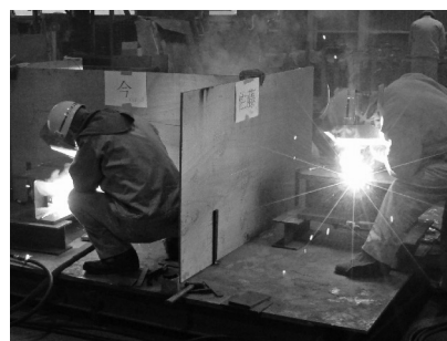
写真2 溶接技量試験
