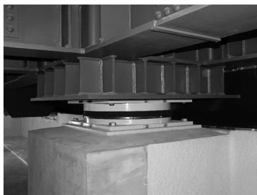
写真5 アリーナ棟屋根支承
