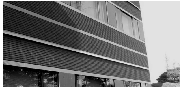
写真4 建物外壁のボーダー
