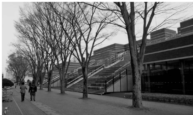
写真1 北側通路からの建物外観
