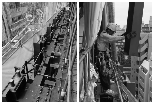
写真3 制震フレーム取付け状況
