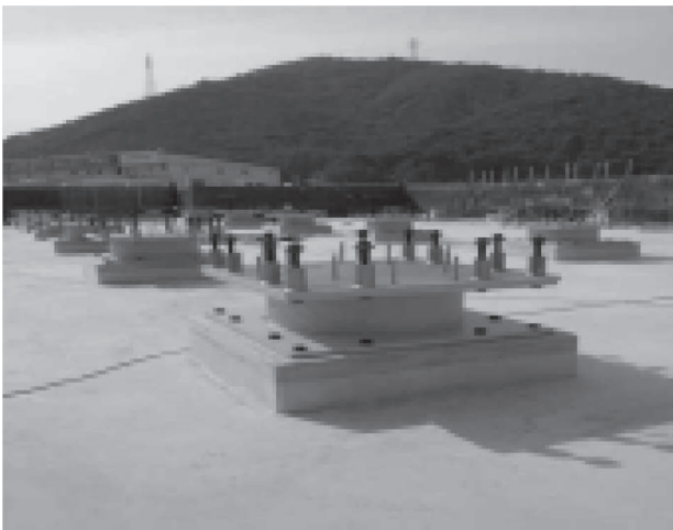
写真7 現場での積層ゴムの設置状況
