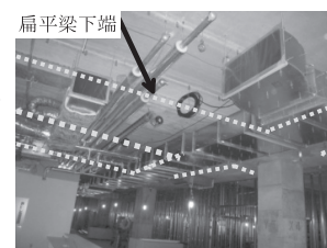
図15 設備設置状況
