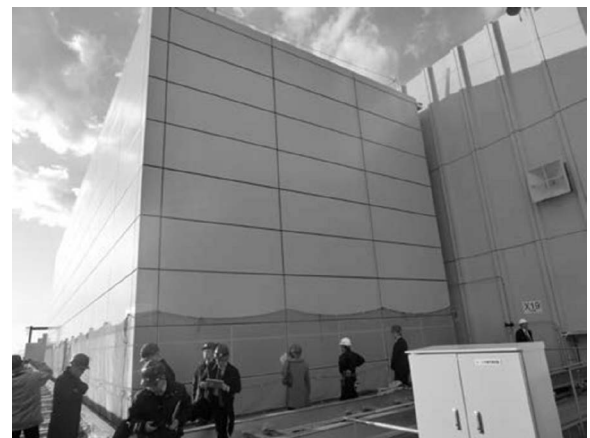
写真8 TMD置場外観
