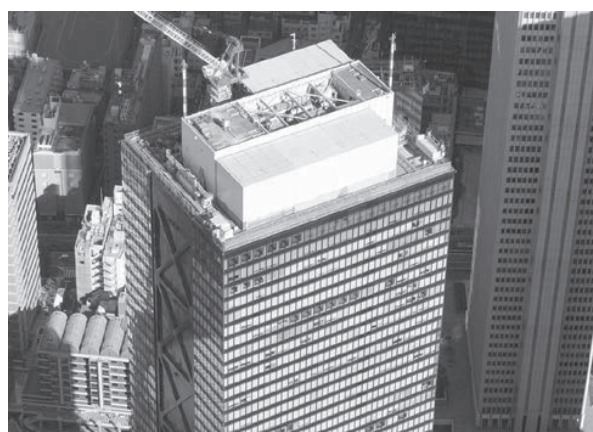
写真5 TMD設置工事中の状況
