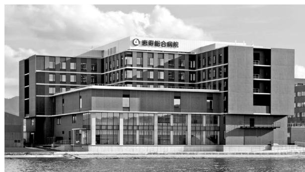
図1 全景写真（北側）
