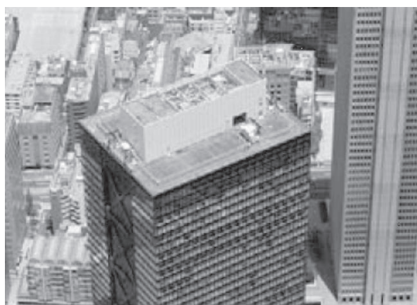
写真4 TMD設置前の屋上の状況
